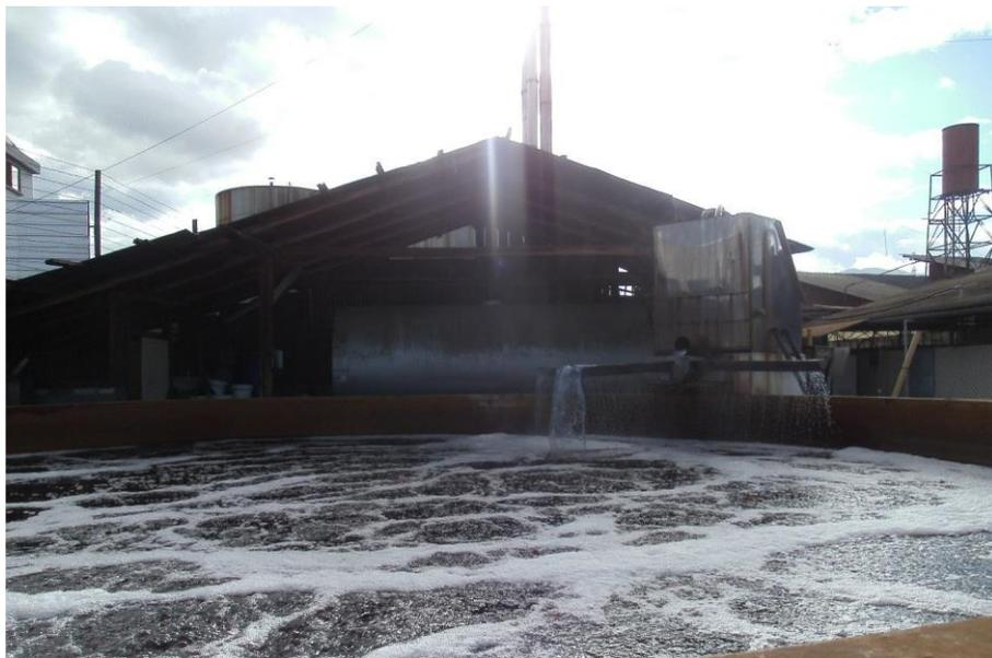
**Figura 31.** Tanque de inicio de depuración de efluentes con capacidad de 318 m<sup>3</sup>
