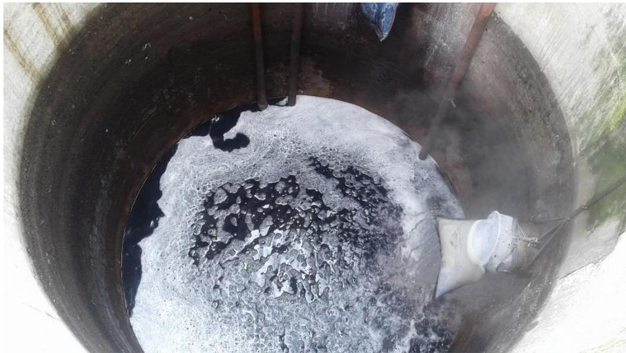
**Figura 30.** Tanque de recolección de efluentes de Tintorería
