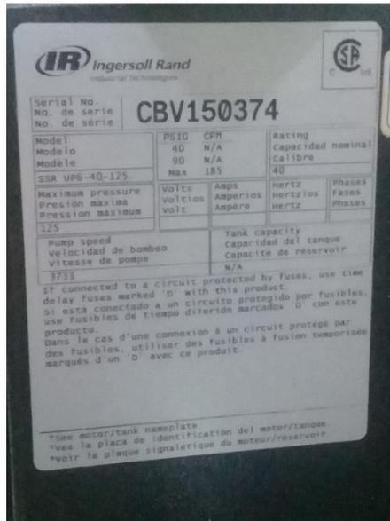
Figura 14: Placa de identificación compresor UP6-40 (COLINEAL, 2018)
