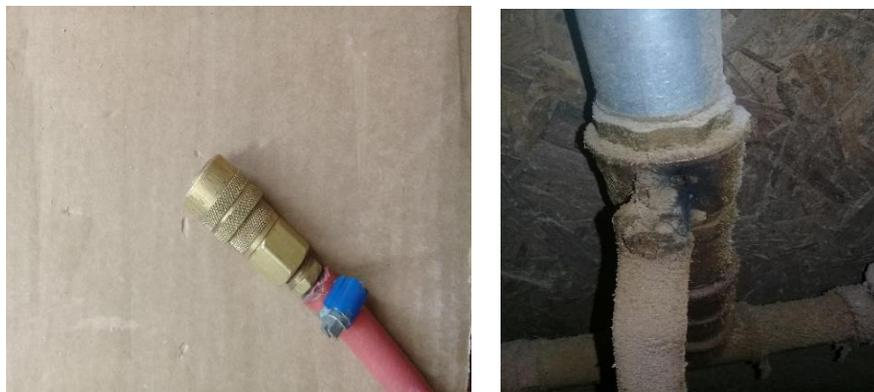
Figura 44: Fuga de aire en líneas de distribución (COLINEAL, 2018)
