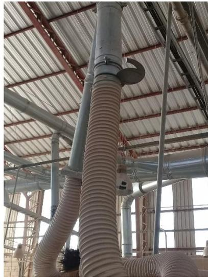
Figura 43: Dámper de absorción abierto (COLINEAL, 2018)
