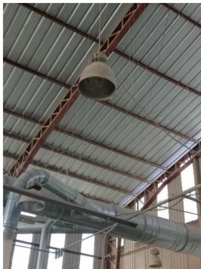
Figura 42: Lámpara de Haluro metálico (COLINEAL, 2018)
