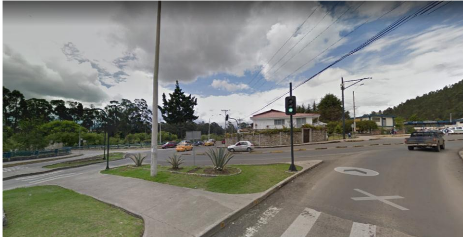
Figura 1. 22 . Intersecciones semaforizadas Fuente: Google Maps
