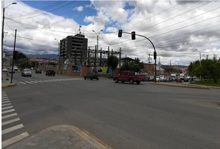
Figura 3. 25 Intersección Av. Max Uhle y Av. Pumapungo.
