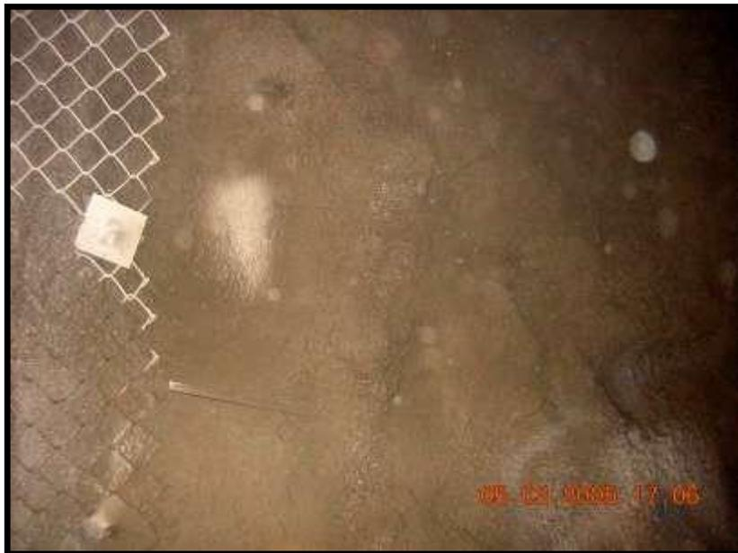
Figura 2.15 Sistema de pernos con malla y shotcrete
