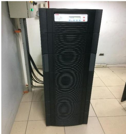
*Ilustración 21: Equipo de respaldo de energía UPS.*
