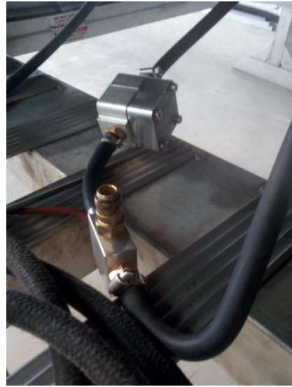
Anexo11h. Conexiones hacia el flujómetro
