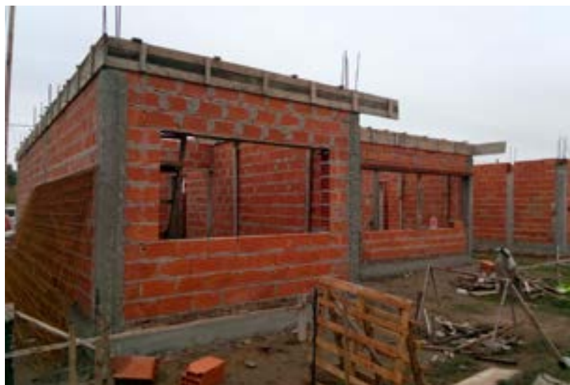
Imagen 8: Sistema constructivo tradicional, vivienda unifamiliar Fuente: Williams A. 2017
