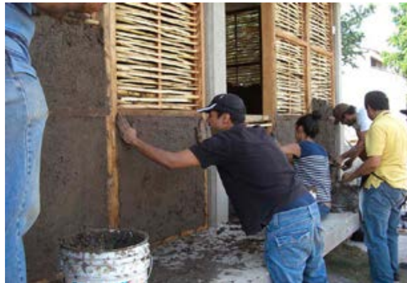
Imagen 18: Bahareque, una técnica constructiva Fuente: Rivera Y, 2006
