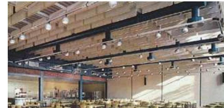
Imagen 26. Ejemplo de tratamiento de un techo a base de baffles rectangulares absorbentes de lana mineral comprimida. Antoni Camón, 1998. Diseño acústico de espacios arquitectónicos.
