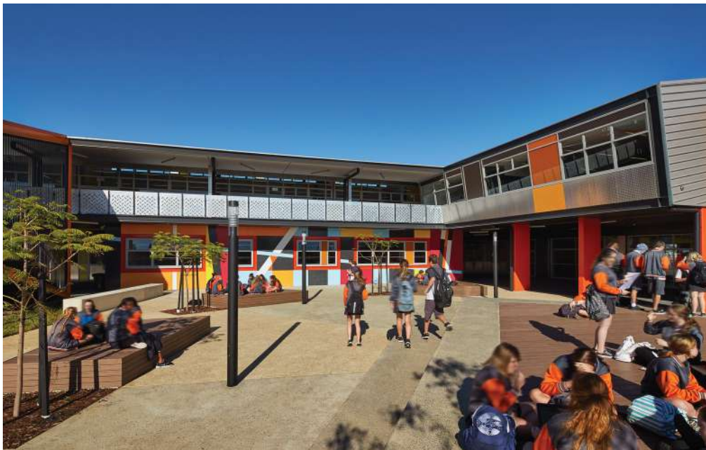
Ilustración 10 Escuela Secundaria Baldivis
