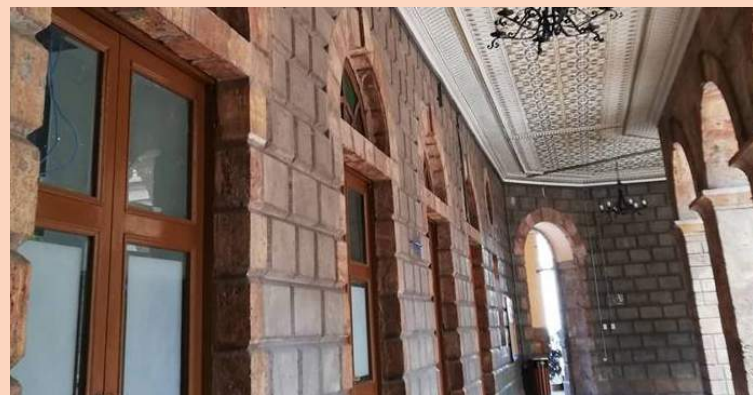
Figura 63: Muros de ladrillo recubiertos de mármol y puertas de madera con ventanales de arco de medio punto.
