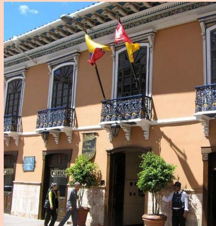
Figura 25: Fachada hotel Santa Lucía.
