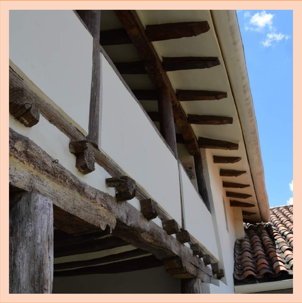
Detalle de vigas de madera en la segunda planta
