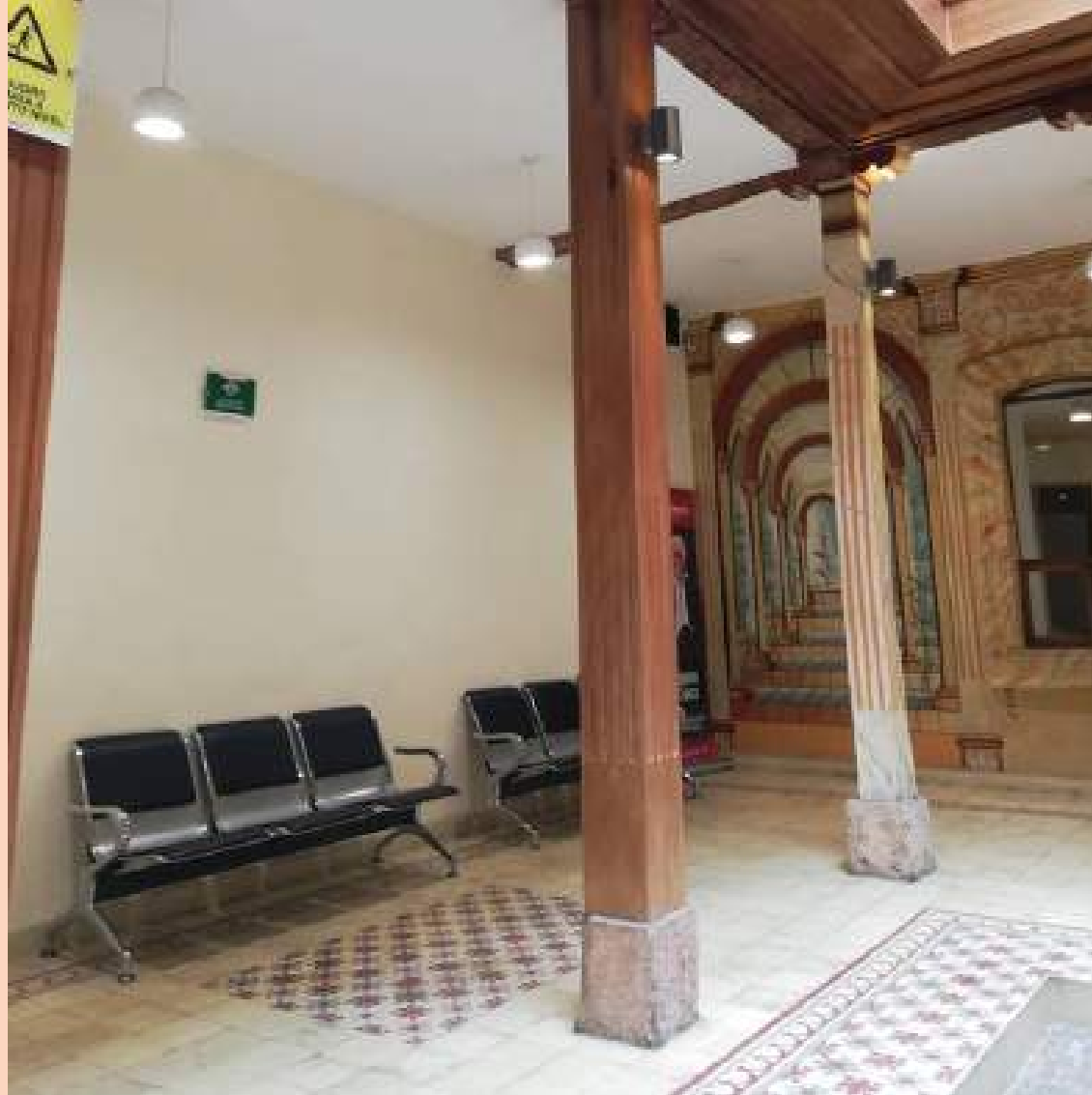
Figura 95: Base de columnas de piedra.
