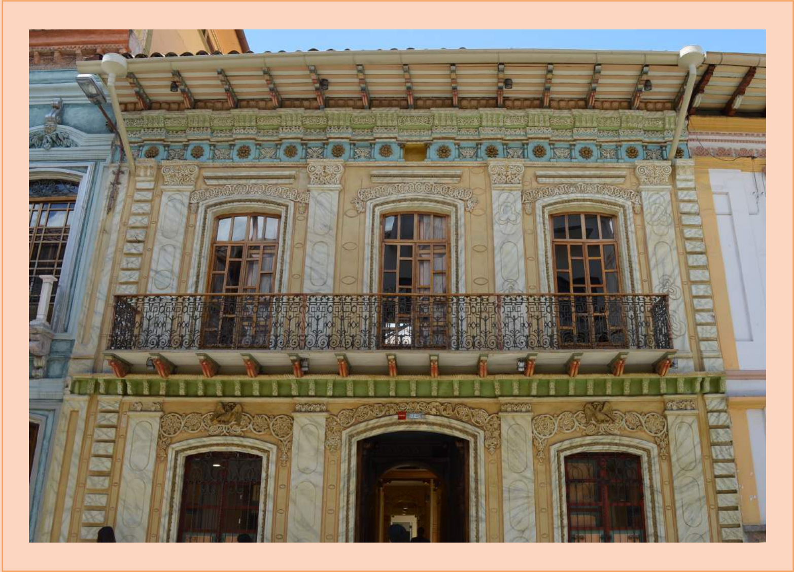
Figura 103: Fachada principal casa de los murales.
