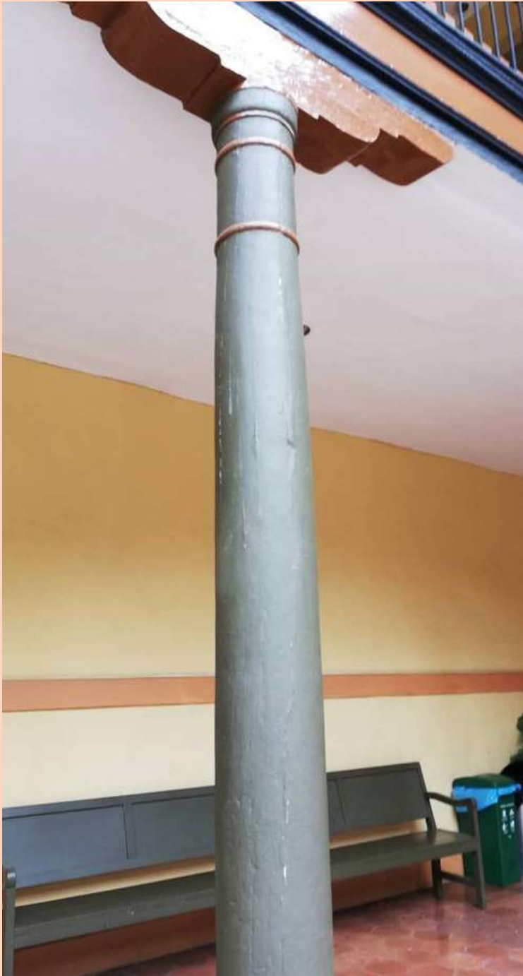
Figura 23: Columnas de madera con soportes curvos Autoría Propia.
