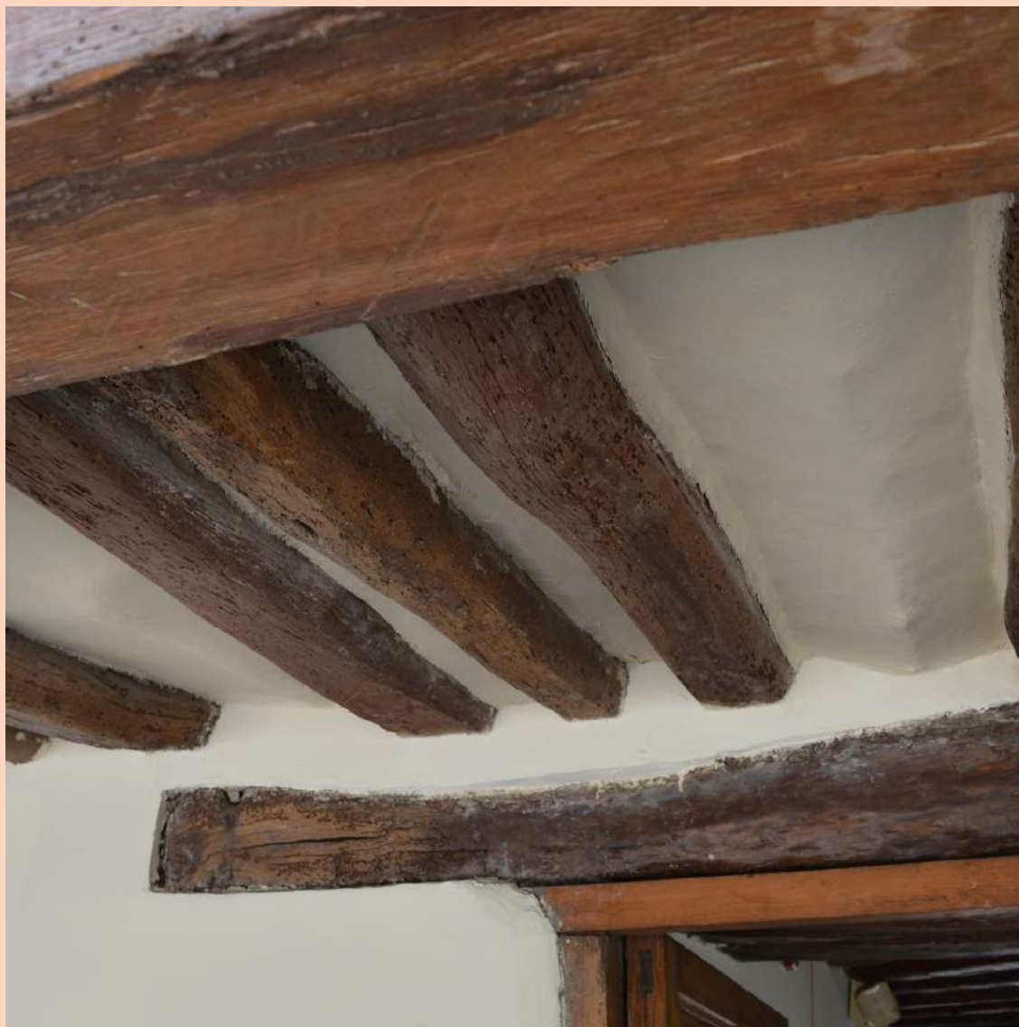
Detalle de vigas de cielo raso y estructura de segunda planta
