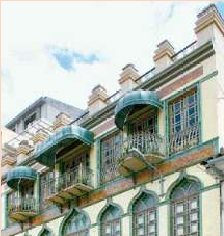
Figura 47: Fachada casa de loza.
