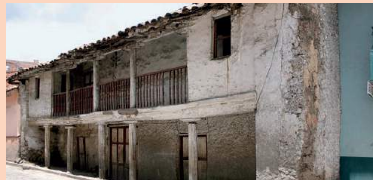
Figura 101: Antigua fachada casa de las posadas.
