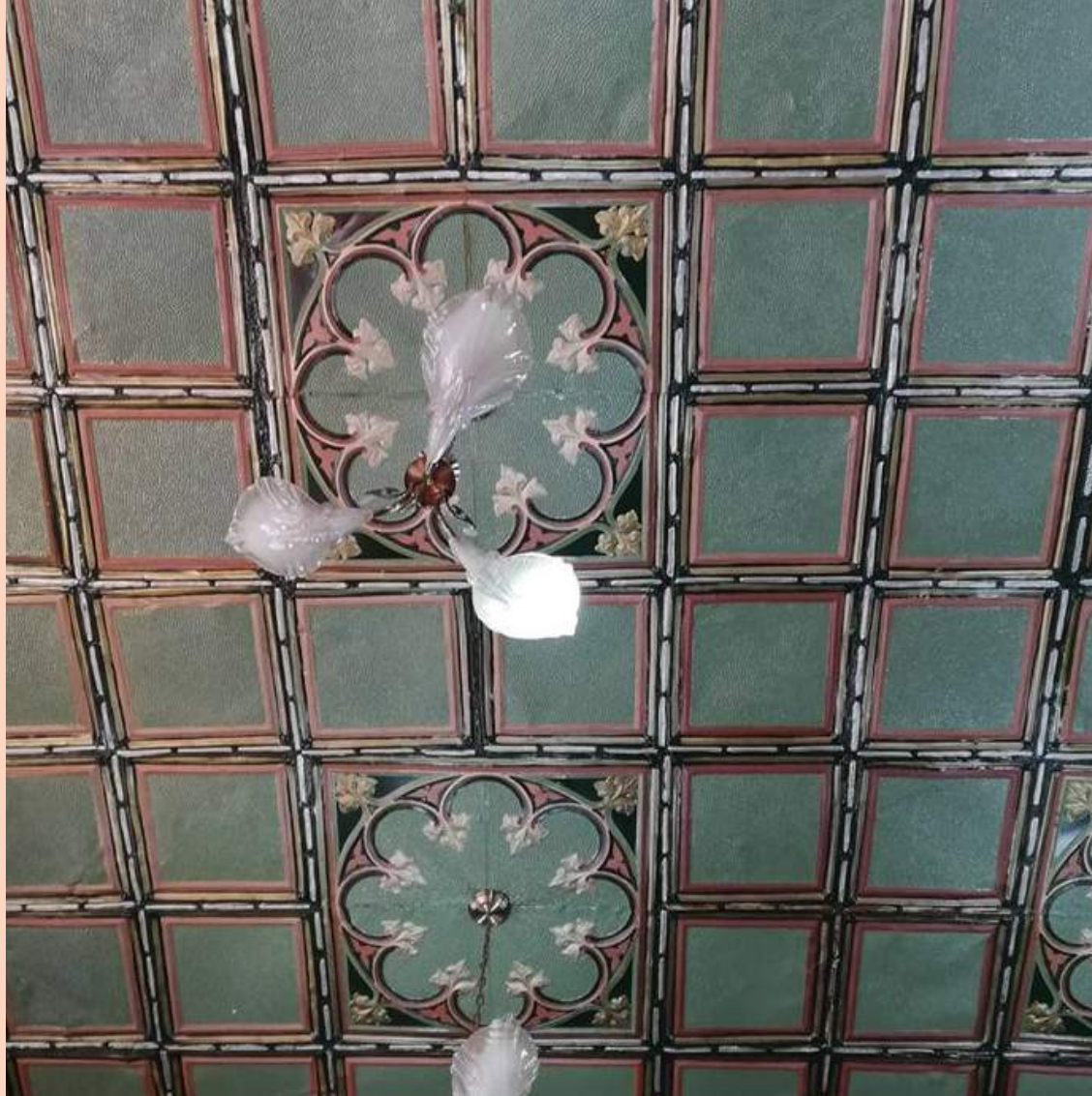
Figura 83: Cielo raso de latón.
