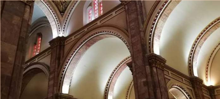
Figura 35: Arcos y bóvedas.
