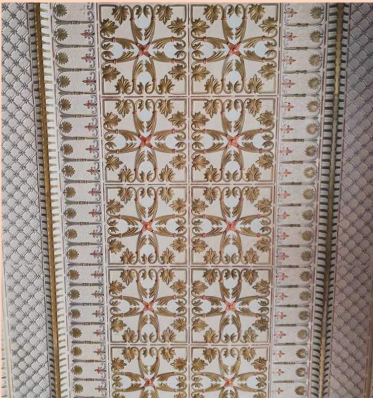
Figura 61: Cielo raso de latón.
