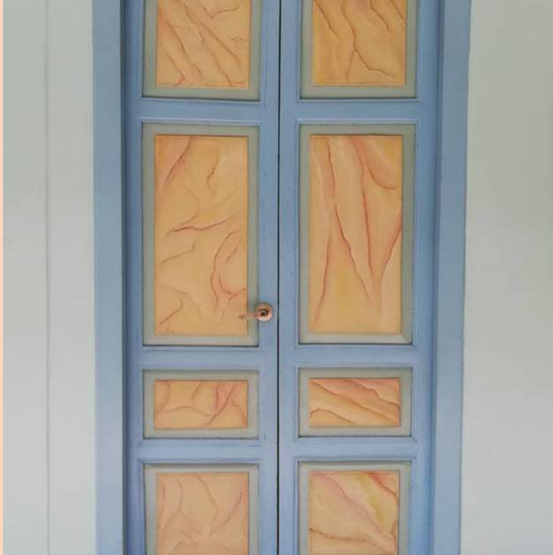
Figura 85: Puerta de madera pintada a mano.
