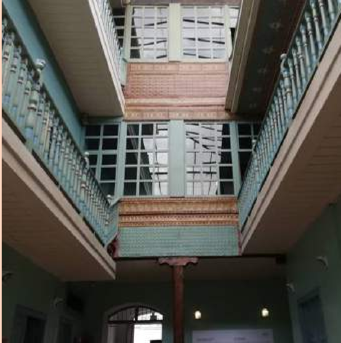
Figura 89: Balcones interiores de madera.
