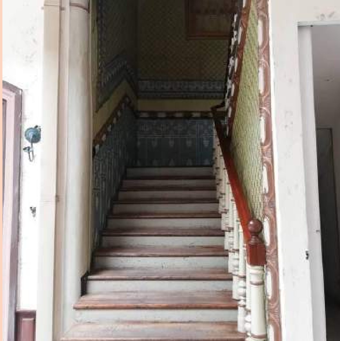
Figura 90: Escaleras de madera.
