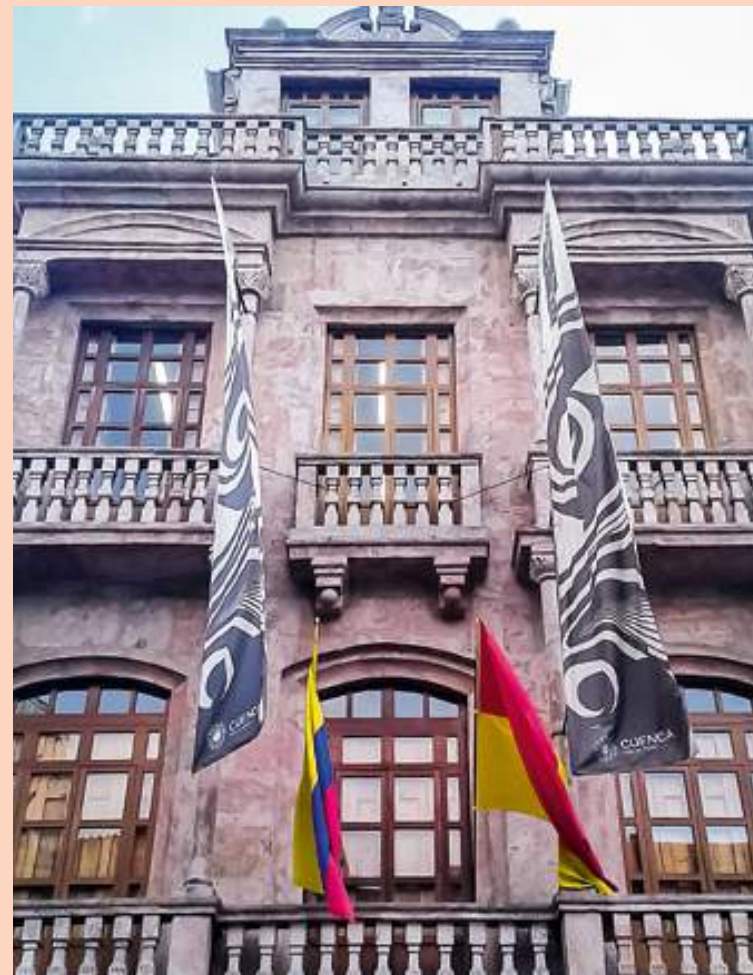
Figura 39: Fachada principal casa de latón
