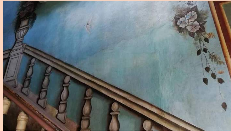
Figura 51: Soportes de madera en pasillo con un fin decorativo.
