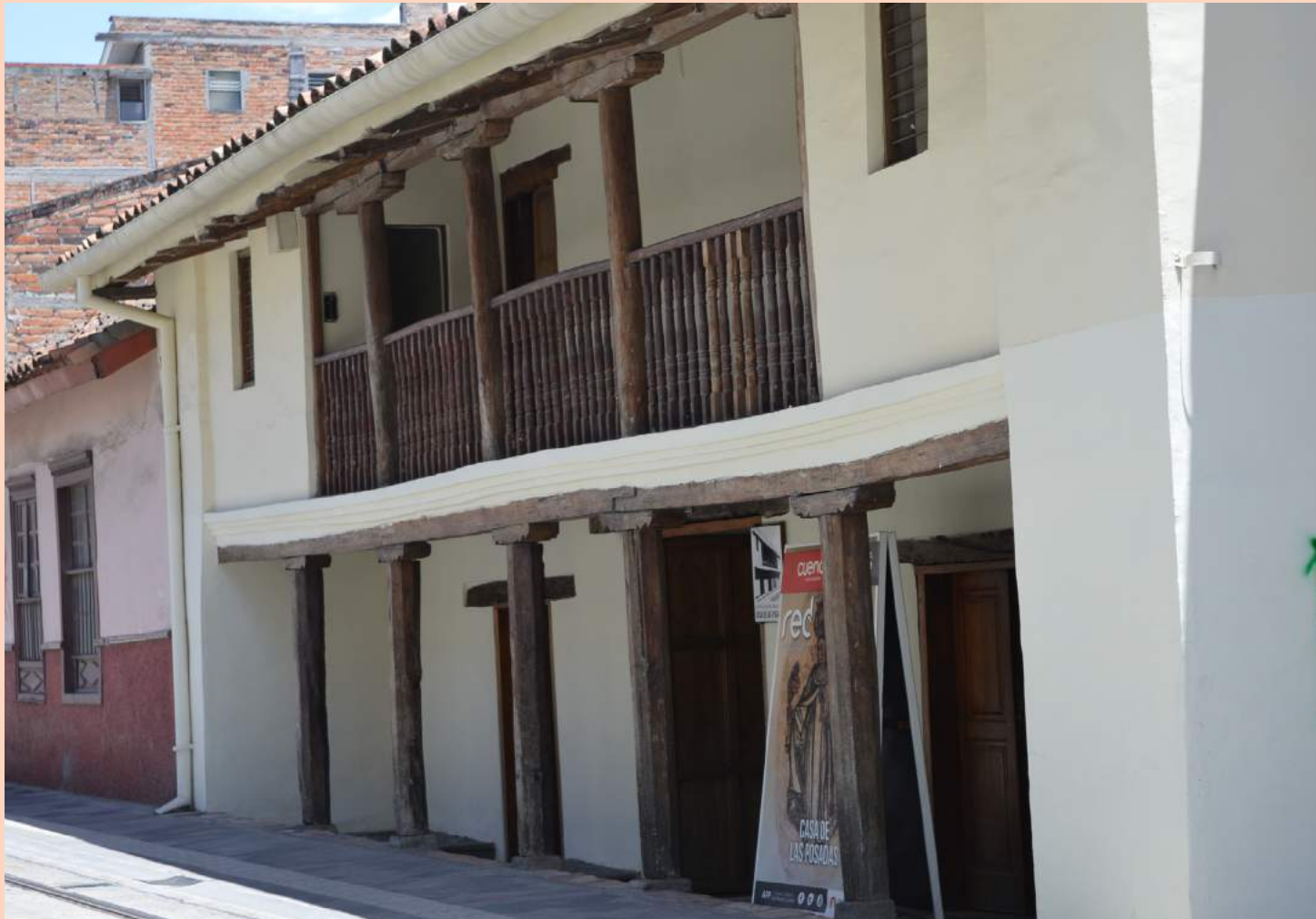
Figura 102: Fachada restaurada casa de las posadas.
