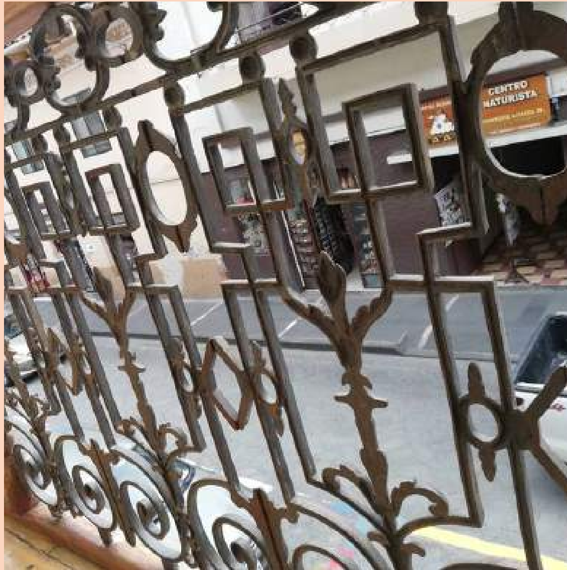
Figura 91: Balcones exteriores de hierro forjado y pasamano de madera.
