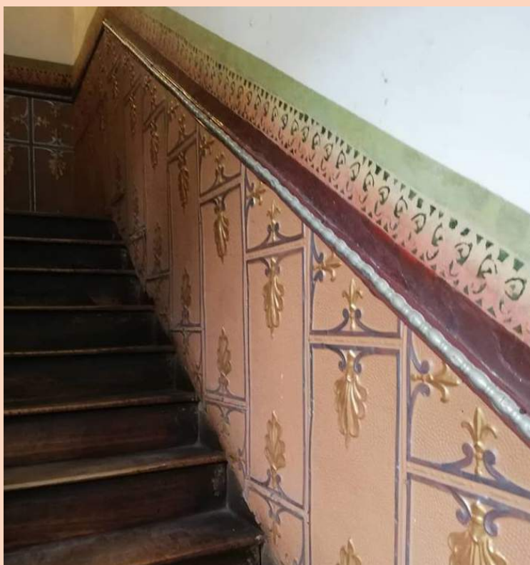
Figura 41: Escalera de madera y pared revestida.
