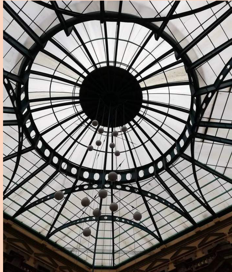
Figura 62: Cubierta de vidrio con estructura denticulada.
