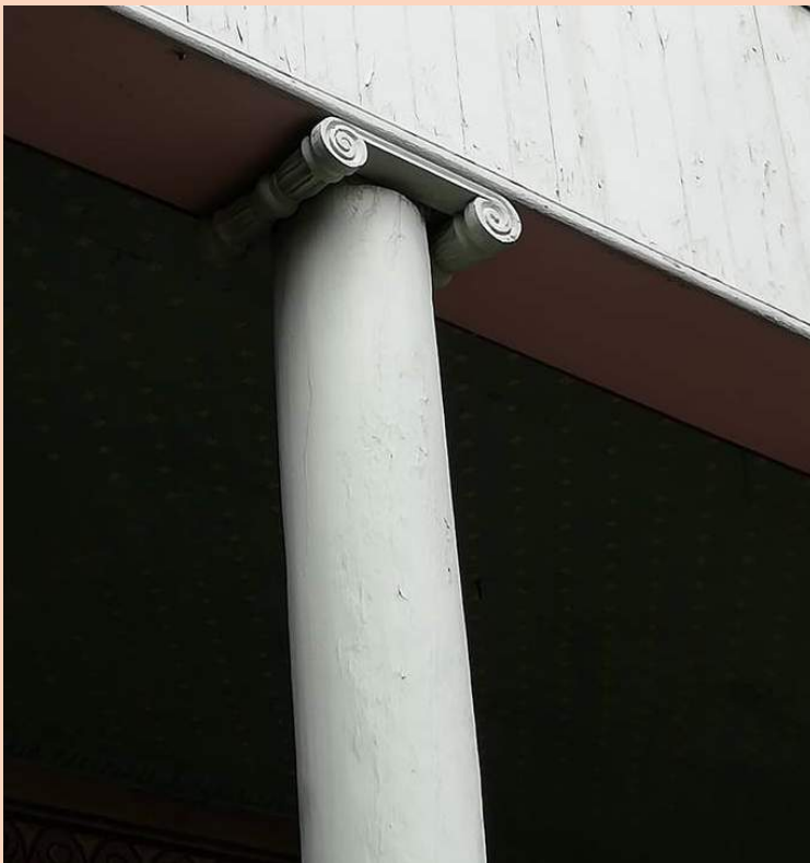
Figura 50: Pilares madera con volutas.
