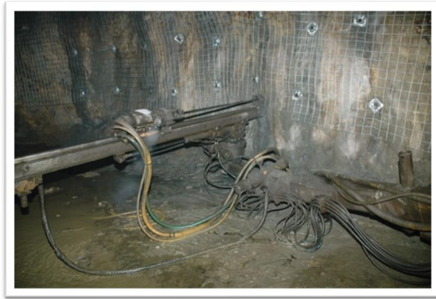
Figura 1.7. Pernos de anclaje. Fuente: (Seguridad Minera, 2017)
