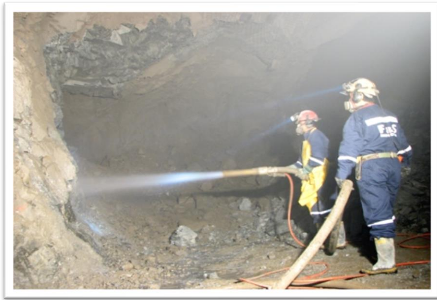
Figura 1.8. Fortificación con shotcrete. Fuente: (Seguridad Minera, 2017)
