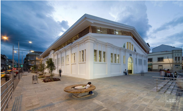
Imagen: foto externa del Mercado 9 de Octubre Fuente: http://bit.ly/2vSNwvC
