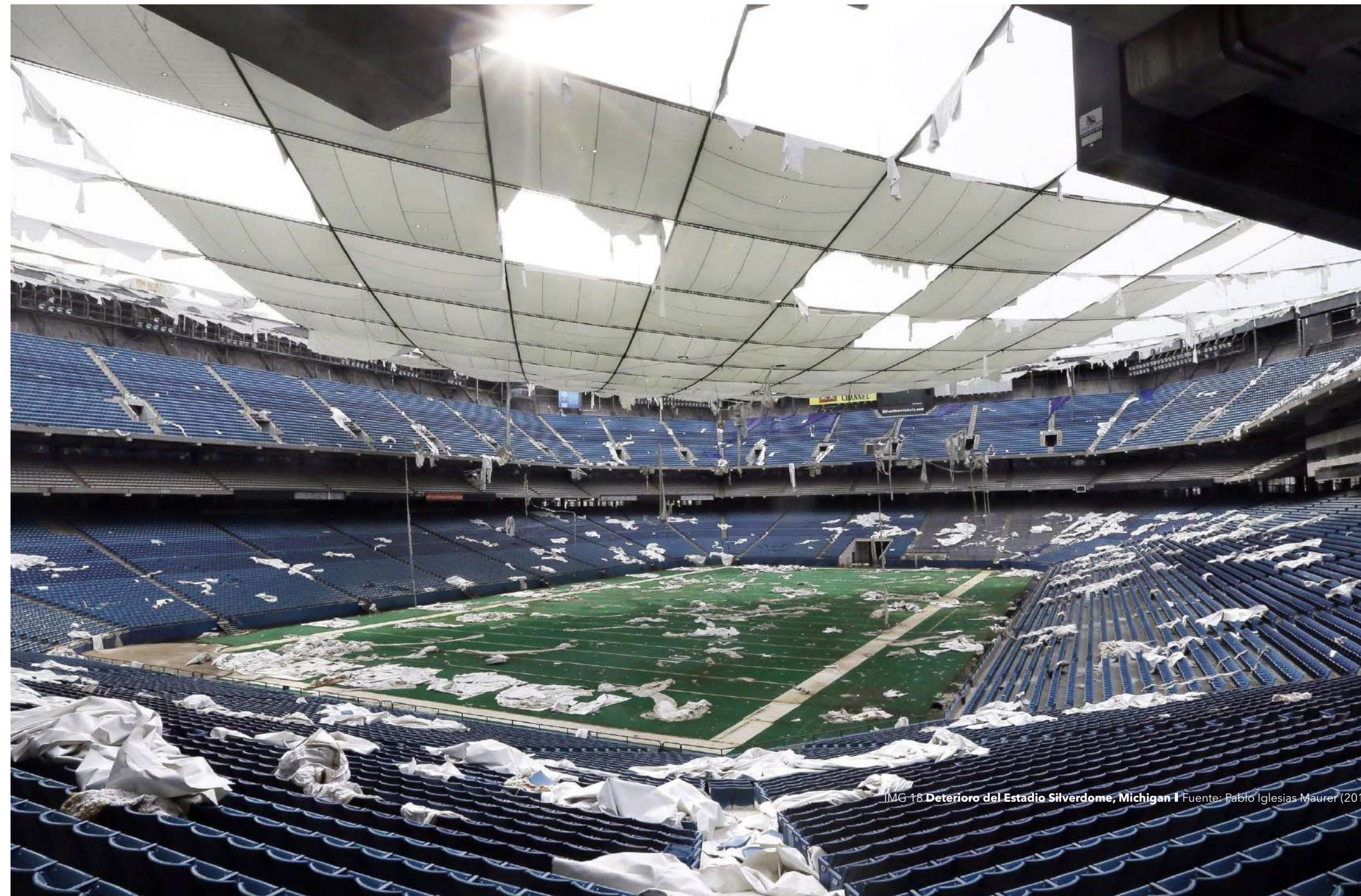
Deterioro del Estadio Silverdome, Michigan
