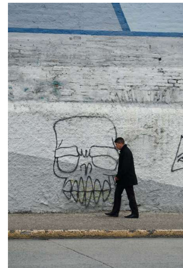
IMG32 Fachada sur | Fuente: Propia
