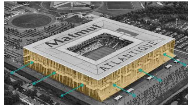
FIG 31 Fachada permeable Fuente: Elaboración propia
