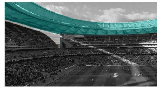
FIG 47 Iluminación escondida en cubierta Fuente: Elaboración propia
