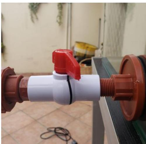
Figura 2-30. Marca de la abertura recomendada de la llave de paso del tanque de entrada.
