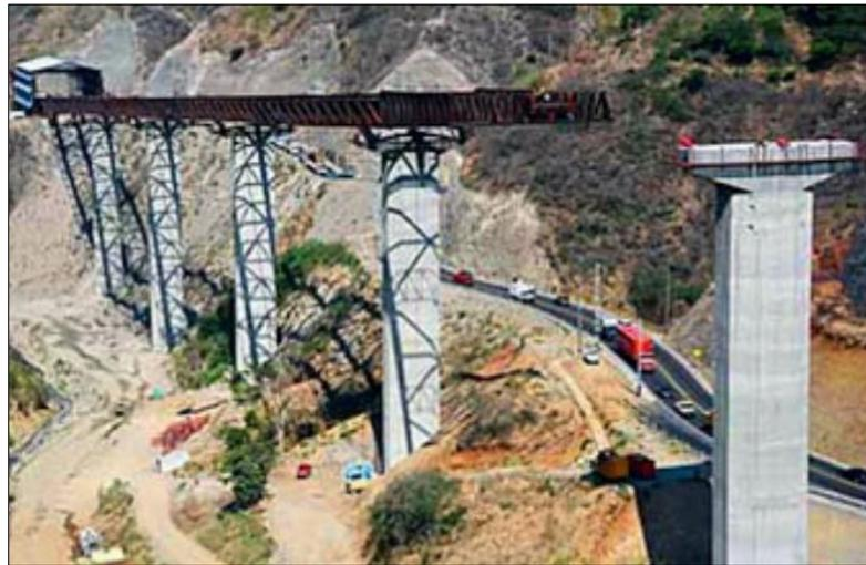
Figura 34 Pilas de una sola columna.
