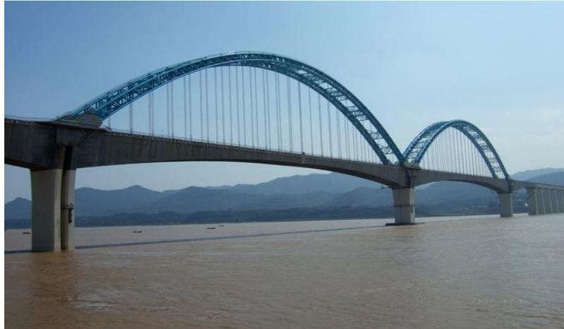
**Figura 7 Puente arco con tablero inferior.**
