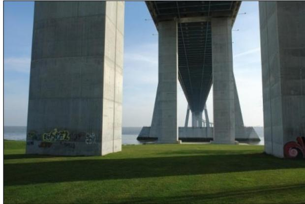
**Figura 32 Pilas tipo muro macizo.**
