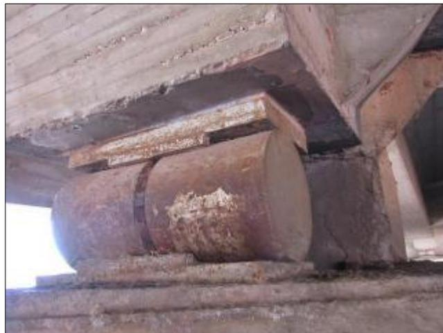
**Figura 37 Apoyo metálico de rodillo.**
