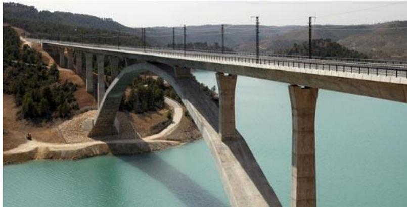
**Figura 5** Puente arco con tablero superior.
