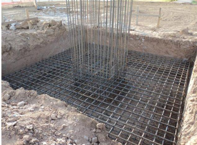
**Figura 41 Zapata aislada.**
