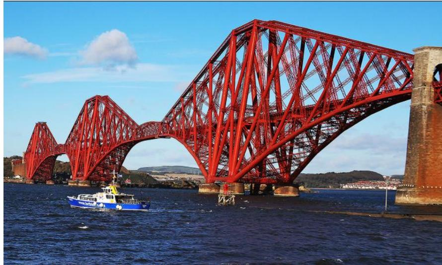
**Figura 20** Puente de Forth en Escosia, Subestructura de viga tipo Gerber.
