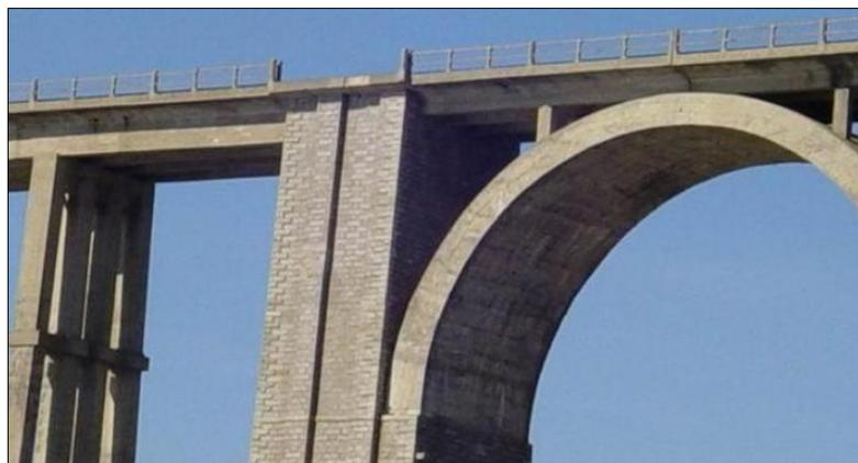
**Figura 33 Pilas de doble muro.**
