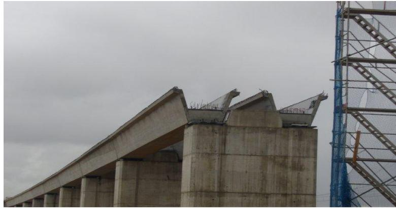
**Figura 8 Puente viga con losa de hormigón pretensado**
