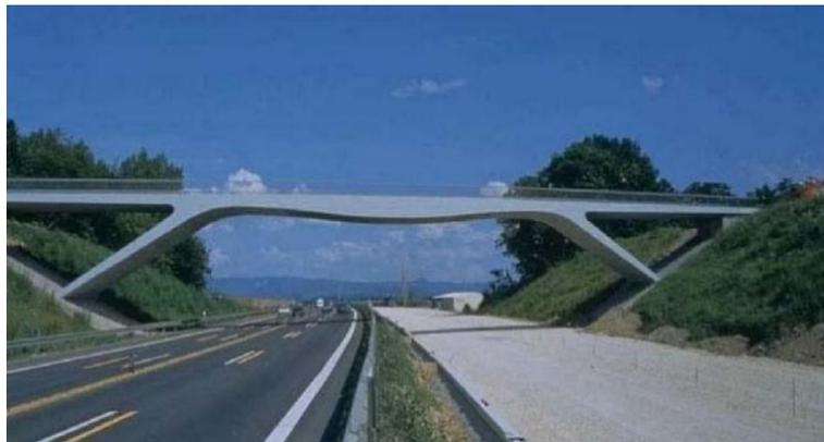
**Figura 9 Puente pórtico con pilares inclinados.**
