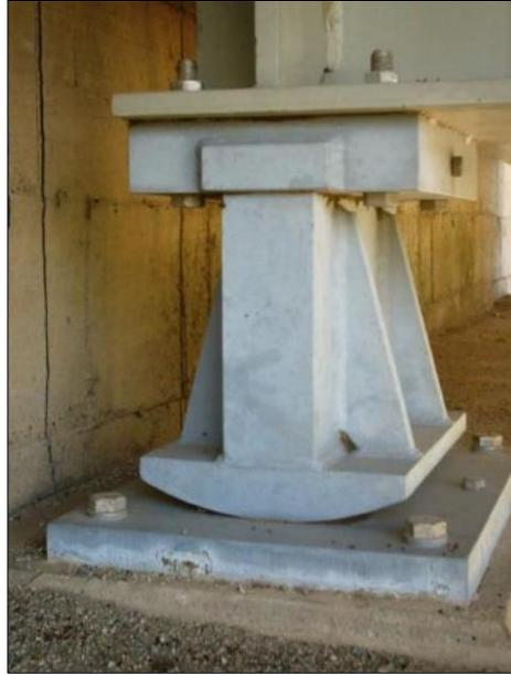
**Figura 36 Apoyo metálico tipo balancín.**
