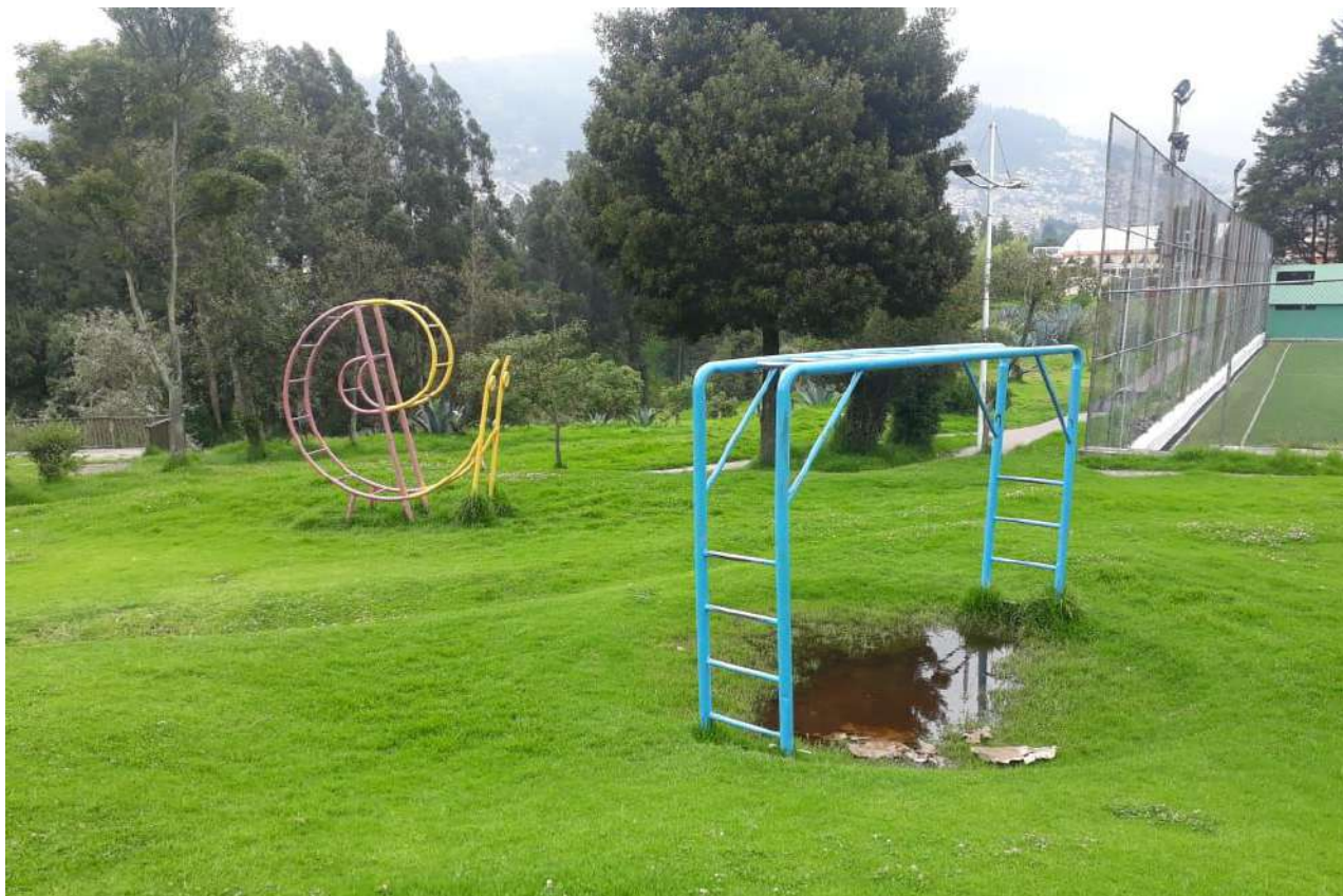
Fotografía 33 , falta de mantenimiento de juegos, día fotografía jueves 4pm Fuente: Autoría
