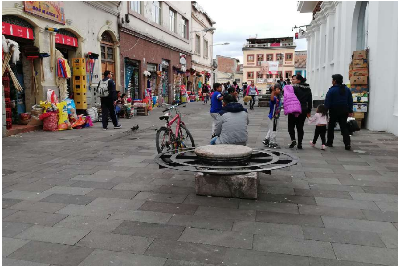
Fotografía 19, deterioro de bancas, retractada un martes a las 9:00 am. Fuente: Autoría
