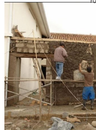
Figura 17. Elaboración de muro Fuente: Orellana 2017
