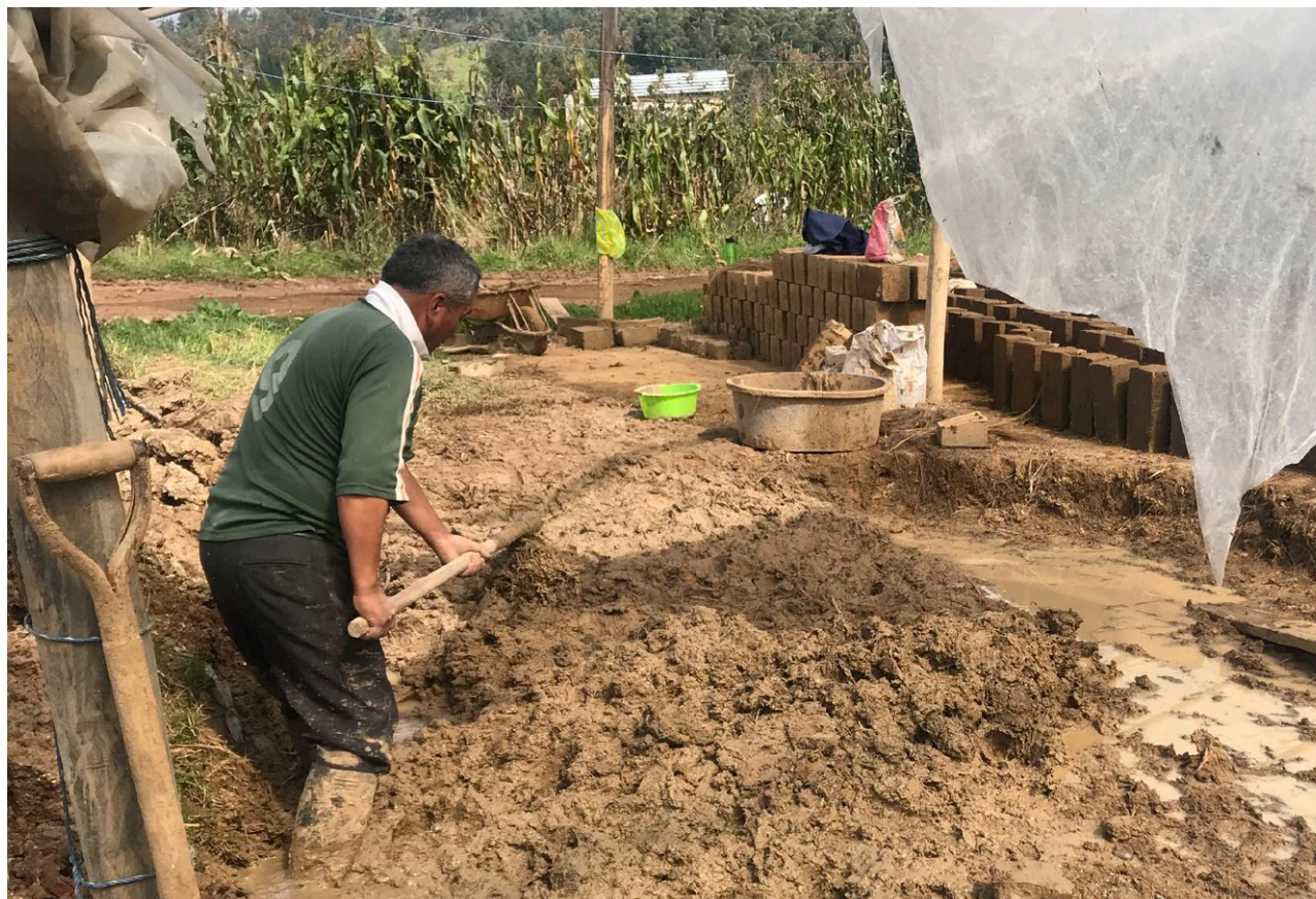
Figura18 . Mezcla de barro para adobe Fuente: Elaboración propia
