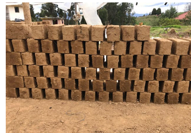
Figura 20. Secado de adobe Fuente: Propia
