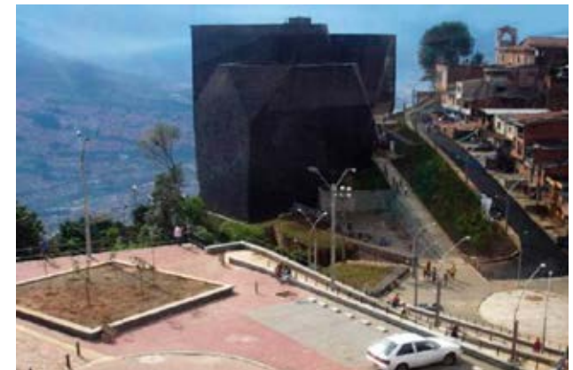
Figura 16 Zona rehabilitada en Medellín Fuente: Issuu
