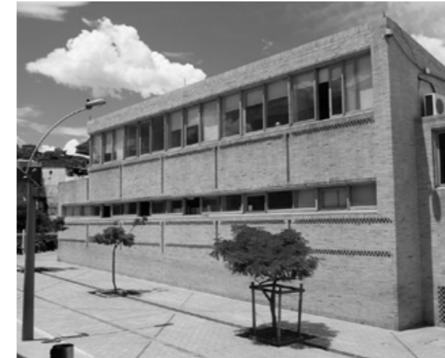
Utilización del ladrillo como material portante y envolvente. Fotografía 8 | Fuente: Ramiro Posada
