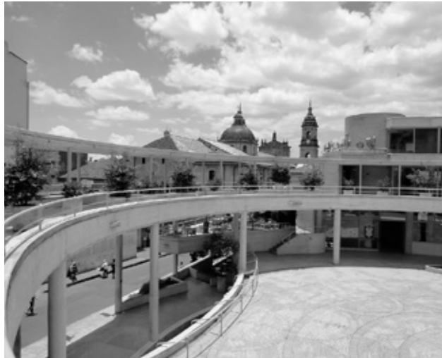
Terrazas y corredores accesibles que resaltan visuales hacia la ciudad Imagen 5 | Fuente: Paula Baldo
