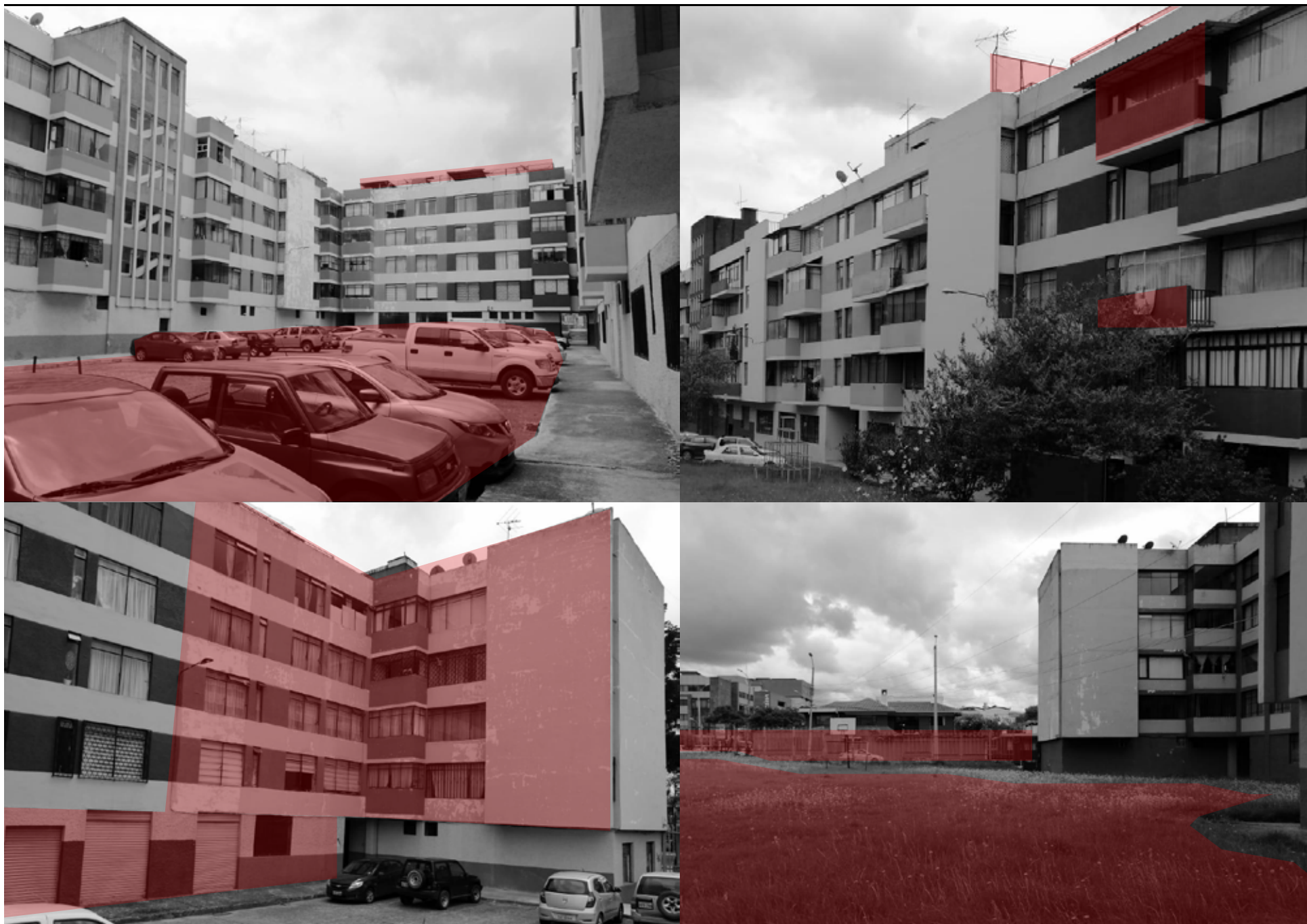
Fig 02. Vistas del estado actual de los Multifamiliares del IESS. Fuente. Autor
