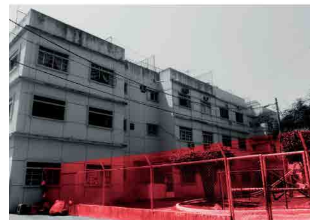
Fig 14. Multifamiliar, vista de errores.
