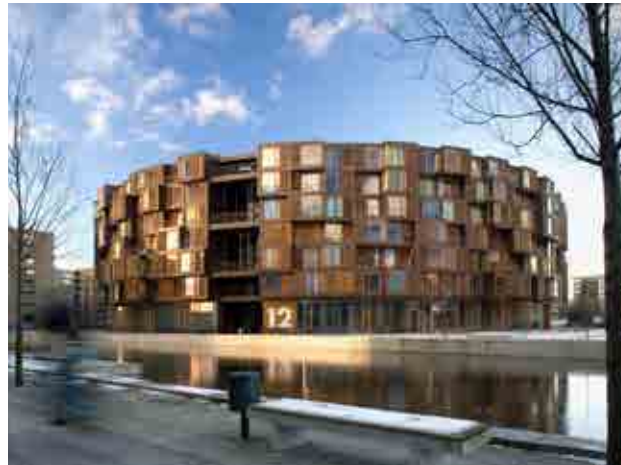
Fig 29. Vista completa del proyecto.
