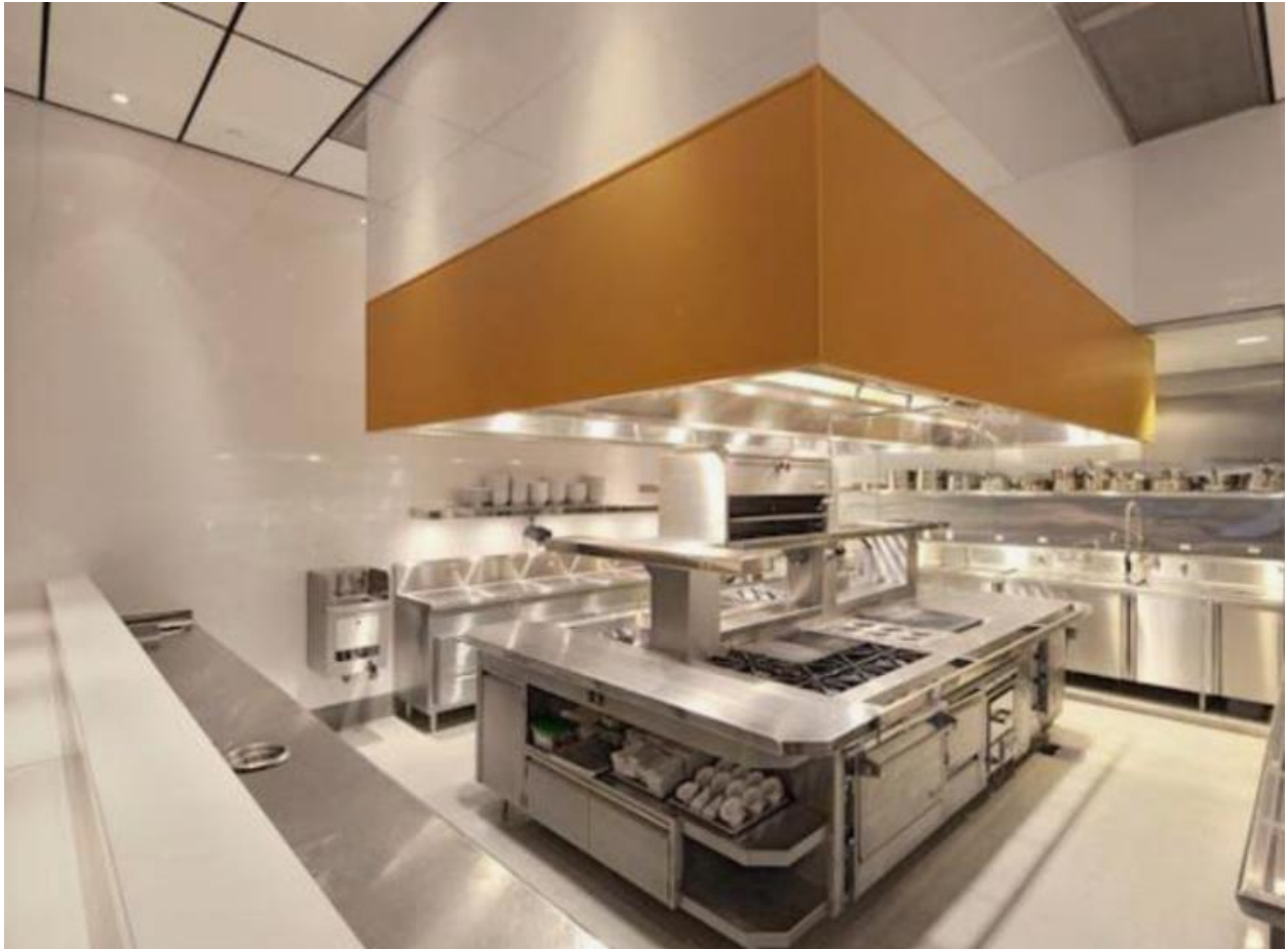
Figura 43 Vista Interior de la cocina
