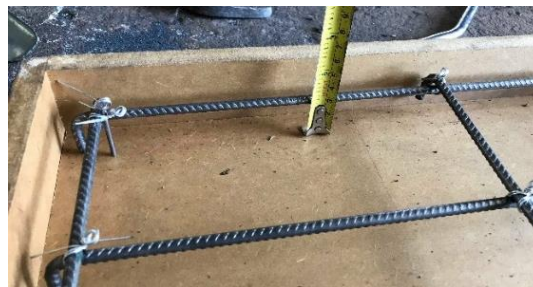
Figura 3-56 Armado de hierros losa maciza, espaciamiento vertical Fuente: Autores
