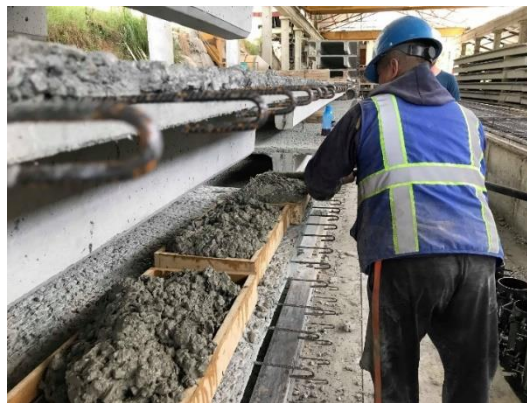
Figura 3-62 Vibrado del hormigón Fuente: Autores
