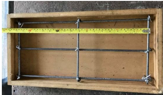
Figura 3-55 Armado de hierros losa maciza, espaciamiento longitudinal. Fuente: Autores
