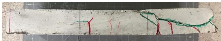
Figura 4-27 Patrón de fisuras de la losa, vista lateral Fuente: Autores
