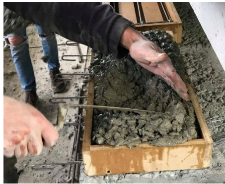
Figura 3-61 Colocación del hormigón en los moldes Fuente: Autores
