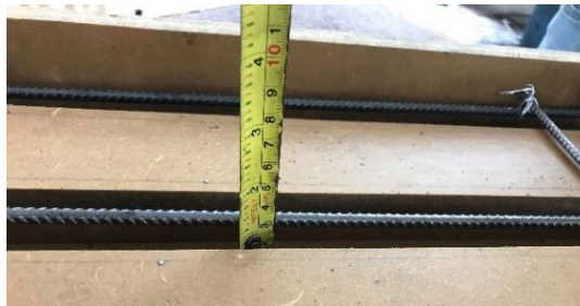
Figura 3-58 Armado de hierros losa unidireccional, espaciado vertical Fuente: Autores
