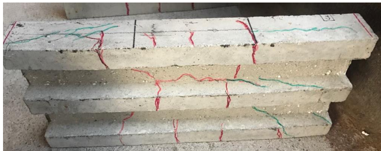
Figura 4-24 Patrón de fisuras de la losa unidireccional, vista en planta Fuente: Autores
