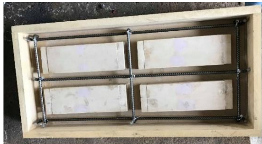
Figura 3-59 Armado de hierros la bidireccional, espaciado longitudinal Fuente: Autores
