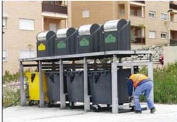
Figura 5.6 Contenedores soterrados de carga posterior.
