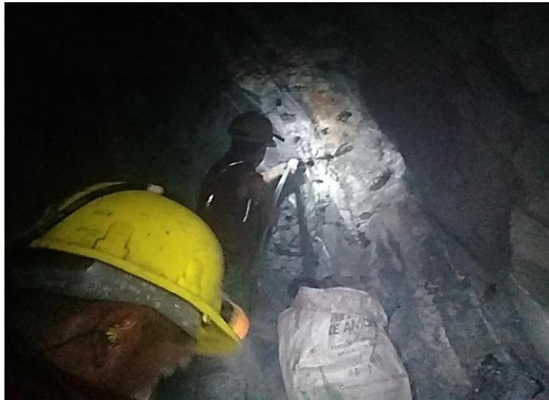
Figura II.3 Colocación de explosivos en la malla de perforación.
