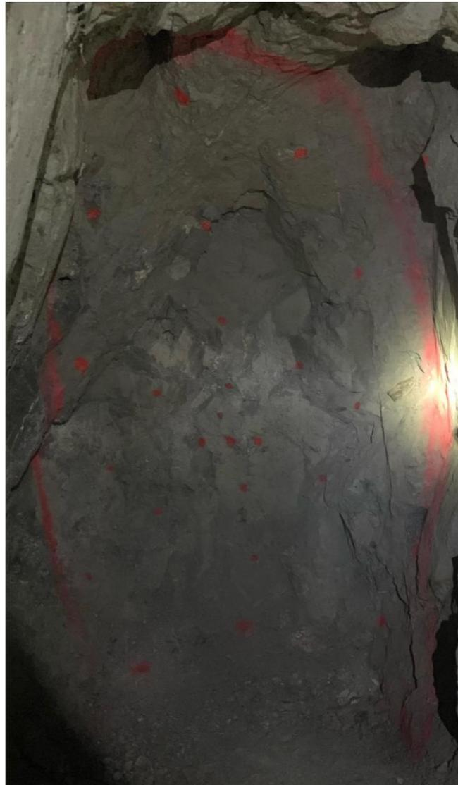
Figura 3. 9: Malla de perforación trazada en el campo.
