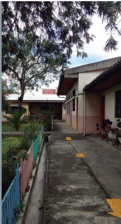
F12. Las veredas perimetrales se encuentran en mal estado, dificultando el tránsito peatonal, la señalización existente es insuficiente. Los pasamanos existentes no están colocados correctamente ya que delimitan el área de circulación.
