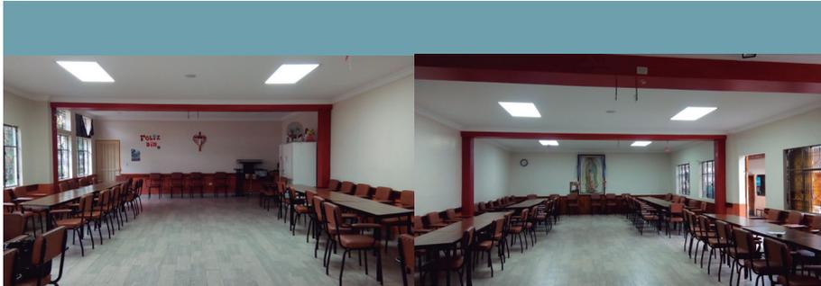
F6. Revestimiento de piso de cerámica maderada, socalo de paredes con enduelado de madera, cielorraso de estuco de yeso lizo en buen estado, el mobiliario existente (sillas) no es ergonómico.
