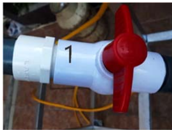
Figura 3-15 Válvula de esfera cerrada
