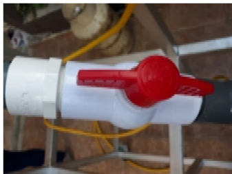
Figura 3-2 Válvula de esfera Abierta
