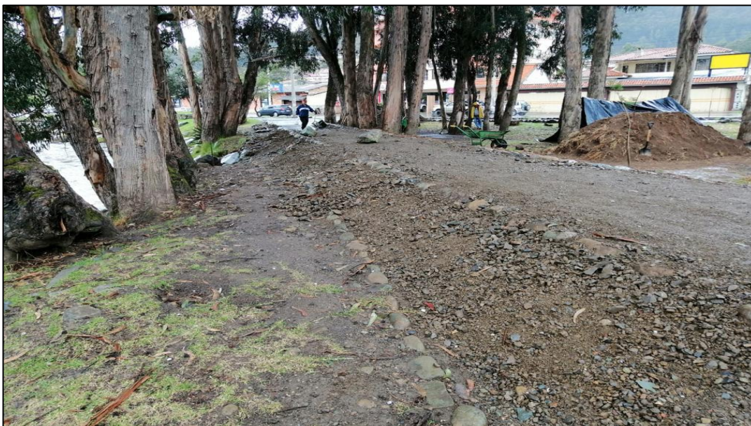
Figura 2.8: Relleno artificial construido en el tramo Puente Felipe II – Tres Puentes Fuente: Autor
