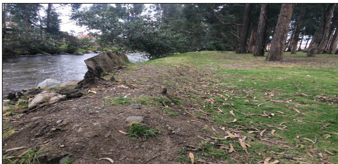
Figura 2.6: Relleno artificial construido en el tramo Calle cantón Chunchi – Calle cantón el Pan Fuente: Autor
