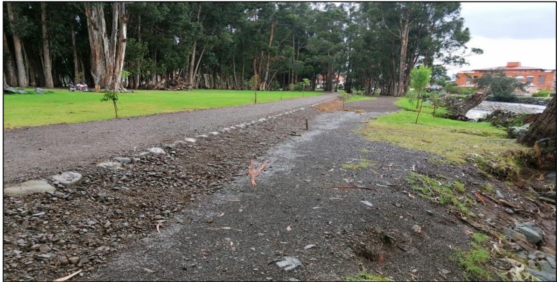
Figura 2.13: Zona crítica Puente Felipe II – Tres Puentes Fuente: Autor
