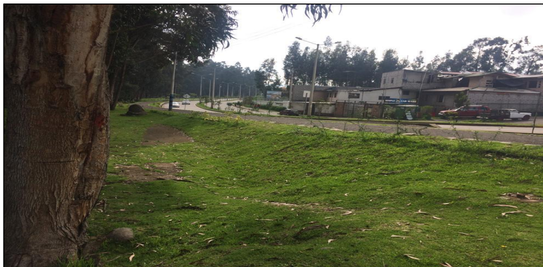
Figura 2.5: Relleno artificial construido en el tramo Puente de Misicata – Calle cantón Zaruma Fuente: Autor
