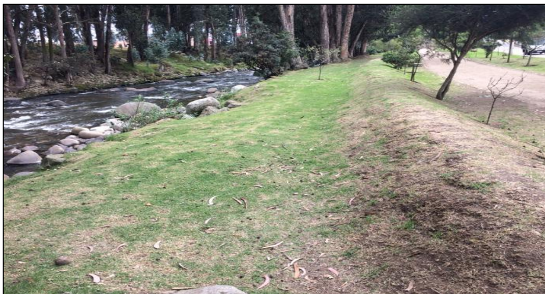
Figura 2.7: Relleno artificial construido en el tramo Calle Dario Ordoñez – Av. De las Américas. Fuente: Autor
