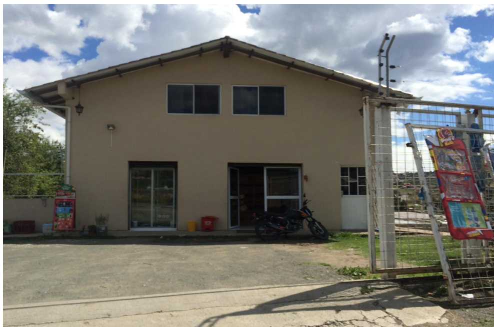
Figura 8. Tienda de Barrio 3
