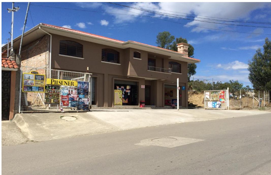
Figura 10. Tienda de Barrio 5
