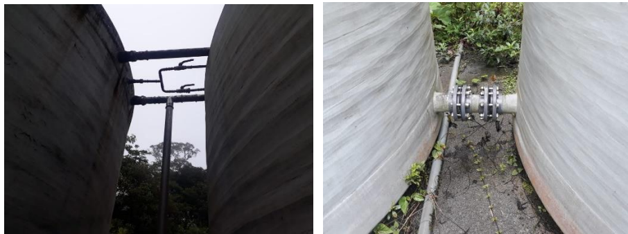
Figura 3.24. Conexiones de llaves y tuberías anexas a los tanques de aireación, STAR Fuente: Autores
