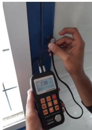
Figura 2.2. Medición del espesor del perfil G con el equipo de END Fuente: Autores
