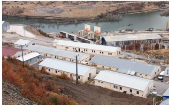
Figura 1.11. Módulos del campamento Sopladora Fuente: Module-T
