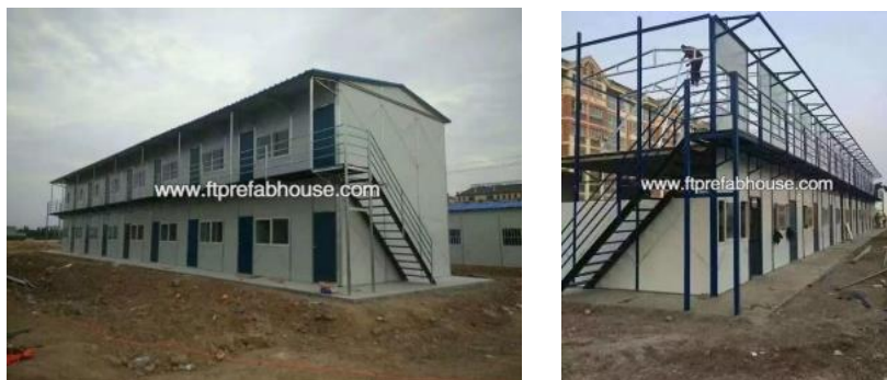
Figura 1.12. Módulo de 2 plantas de prefabhouse Fuente: ftprefabhouse
