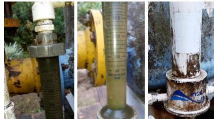
Figura 3.17. Evacuación de residuos especiales, STAP
