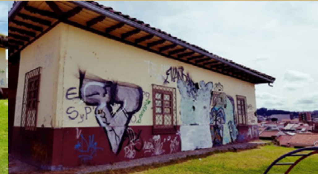
Ilustración 37: Vista lateral derecha, Federación de Barrios de Cuenca
