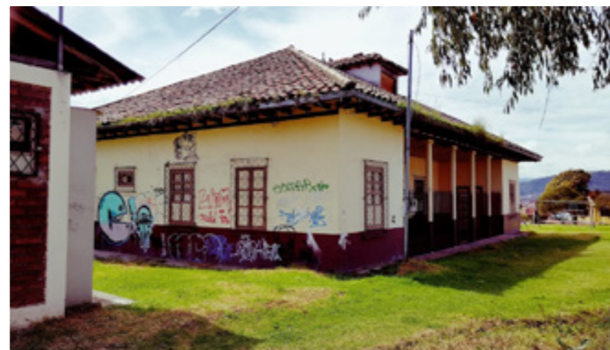
Ilustración 13: Vista Lateral/ Federación de Barrios
