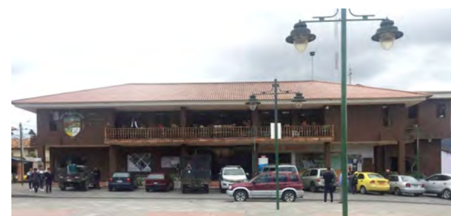
Imagen 8: Fachada Frontal del Gad Municipal de Nabón Fuente: Autoras, 2020
