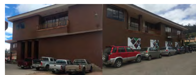
Imagen 10: Fachada lateral derecha y lateral izquierda del Gad Municipal de Nabón. Fuente: Autoras, 2020.
