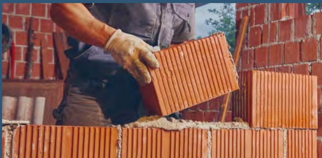
Imagen 52: Aislación térmica ladrillo Fuente: (7 diferencias ladrillo)
