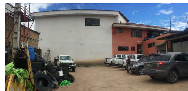
Imagen 9: Fachada Posterior del Gad Municipal de Nabón. Fuente: Autoras, 2020
