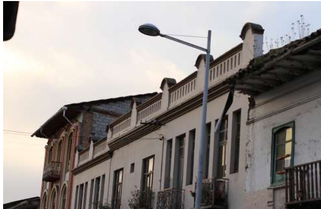
2. Vista del Remate Fuente: Propia
