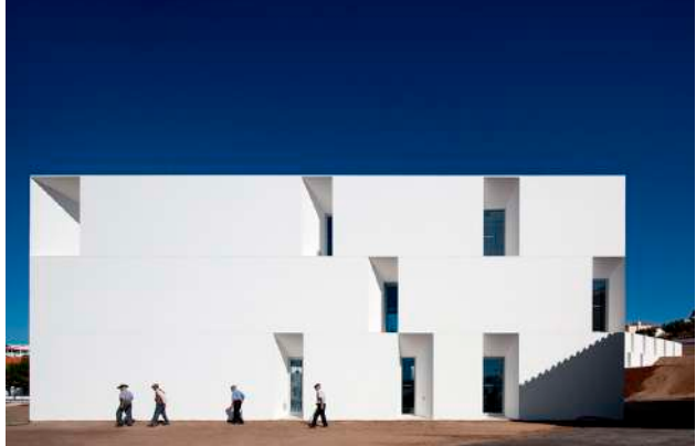
IMG 38 Vista exterior del proyecto Fuente: https://www.plataformaarquitectura.cl/cl/02-300123/alcacer
