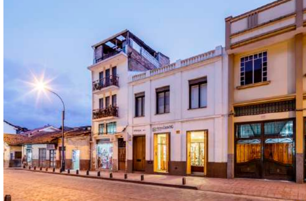
IMG 40 Vista exterior del proyecto Fuente: https://www.bicubik.photo/projects/casa-del-nogal-cuenca
