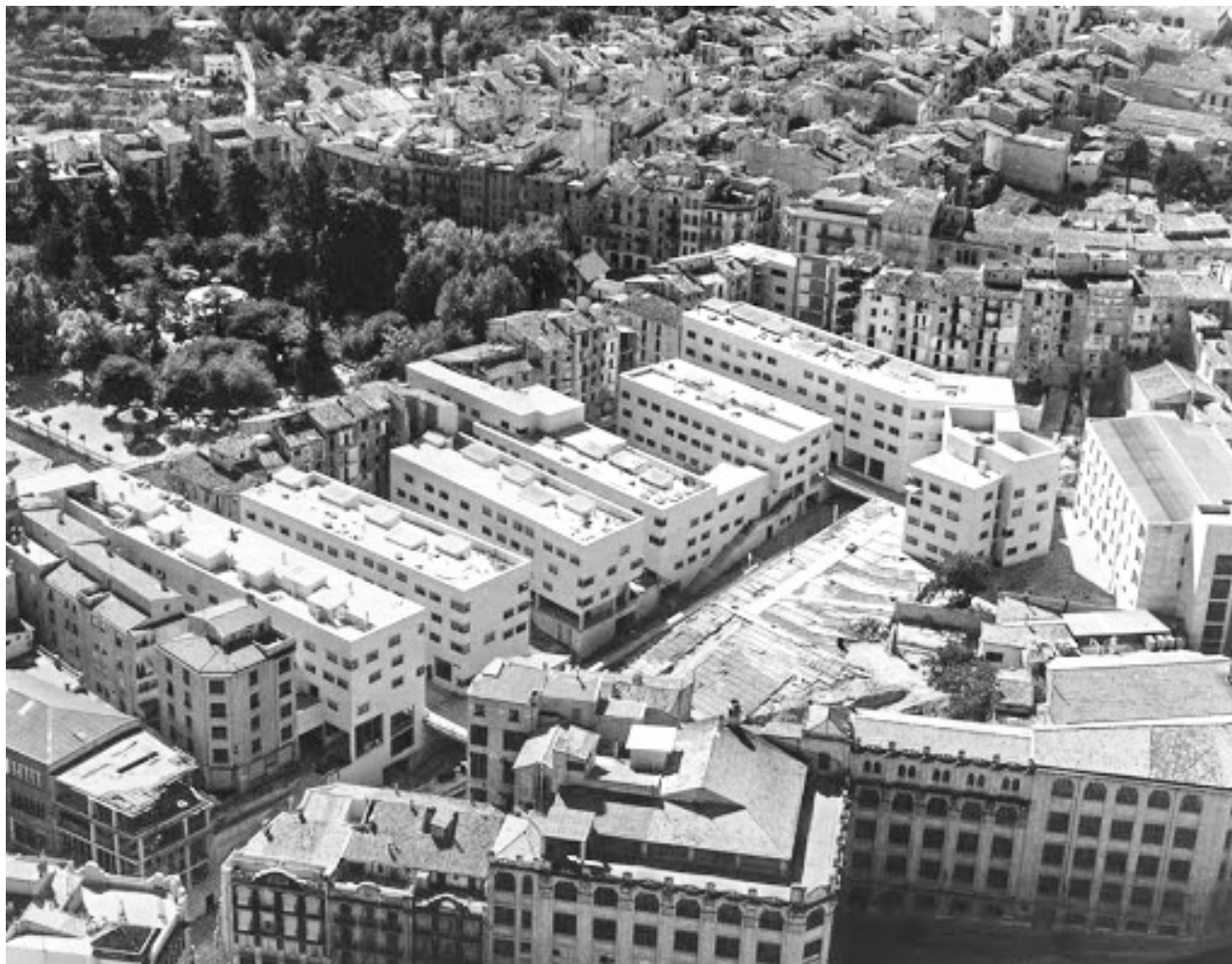
IMG 12 VISTA GENERAL DEL BARRIO LA SANG. FUENTE: JPARQUITECTE
