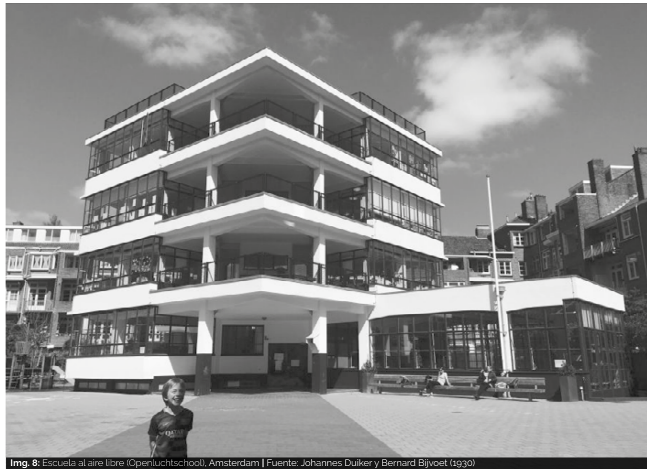
Img. 8: Escuela al aire libre (Openluchtschool), Amsterdam | Fuente: Johannes Duiker y Bernard Bijvoet (1930)
