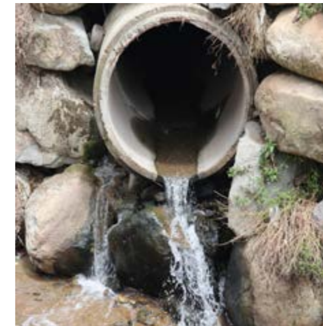
fotografía 52. Desagüe de agua fuente: Elaboración propia
