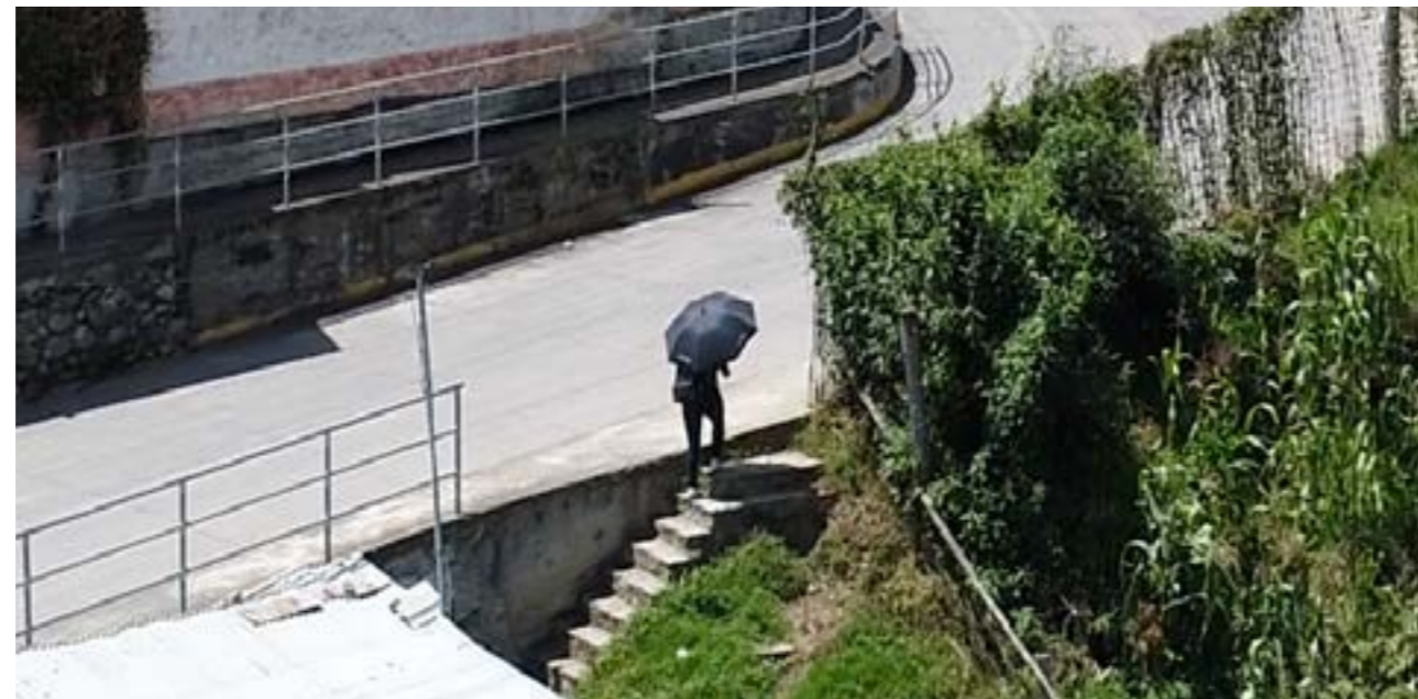
fotografía 79. Escalinatas Barrio Lazareto fuente: Lotes vacíos
