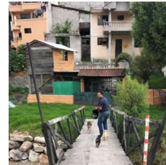
fotografía 36. Puente peatonal fuente: Elaboración propia
