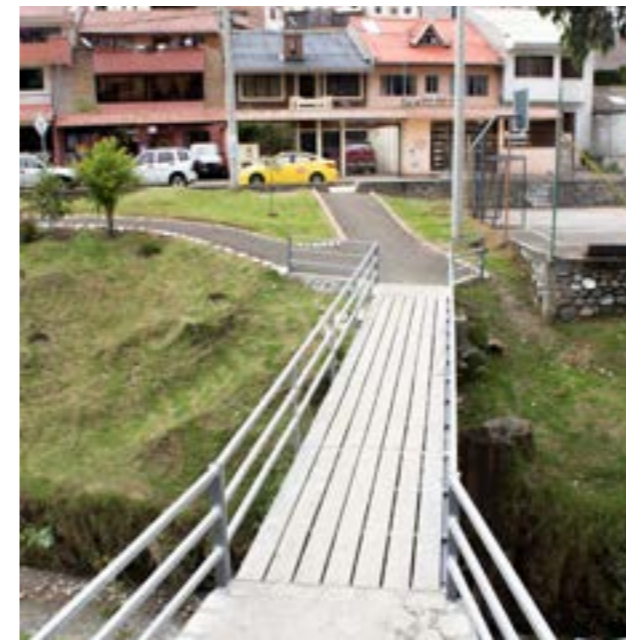
fotografía 31. Gradas para llegar al nivel de la calle fuente: Elaboración propia
