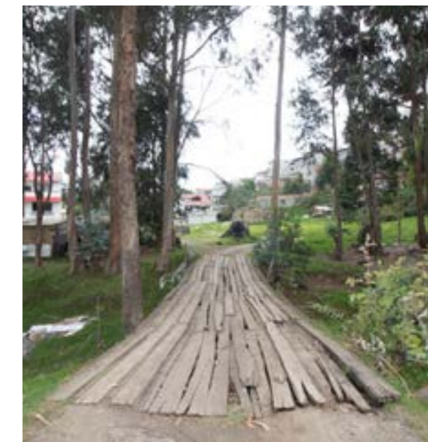
fotografía 89. Puente peatonal de madera fuente: Elaboración propia
