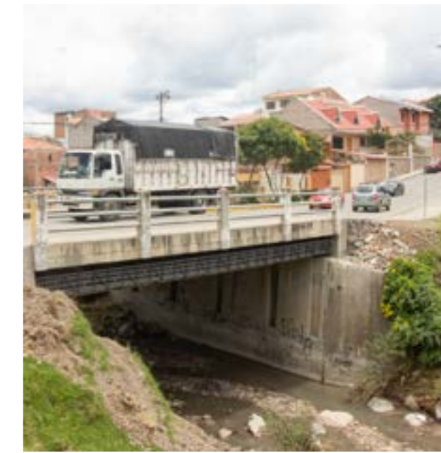
fotografía 64. Puente vehicular fuente: Elaboración propia
