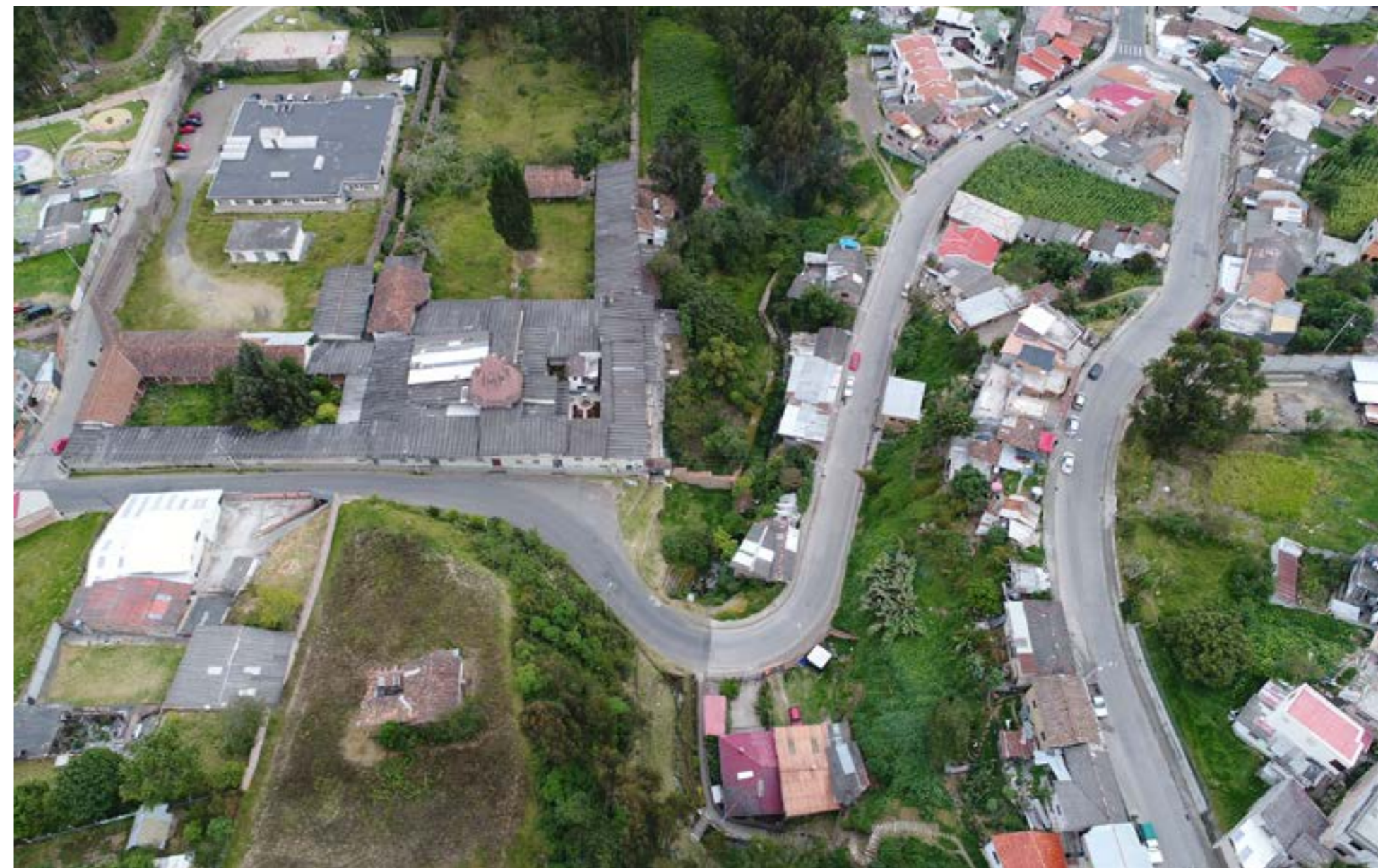
fotografía 17. Foto aérea del Barrio Lazareto - Sector Bellavista fuente: Elaboración propia
