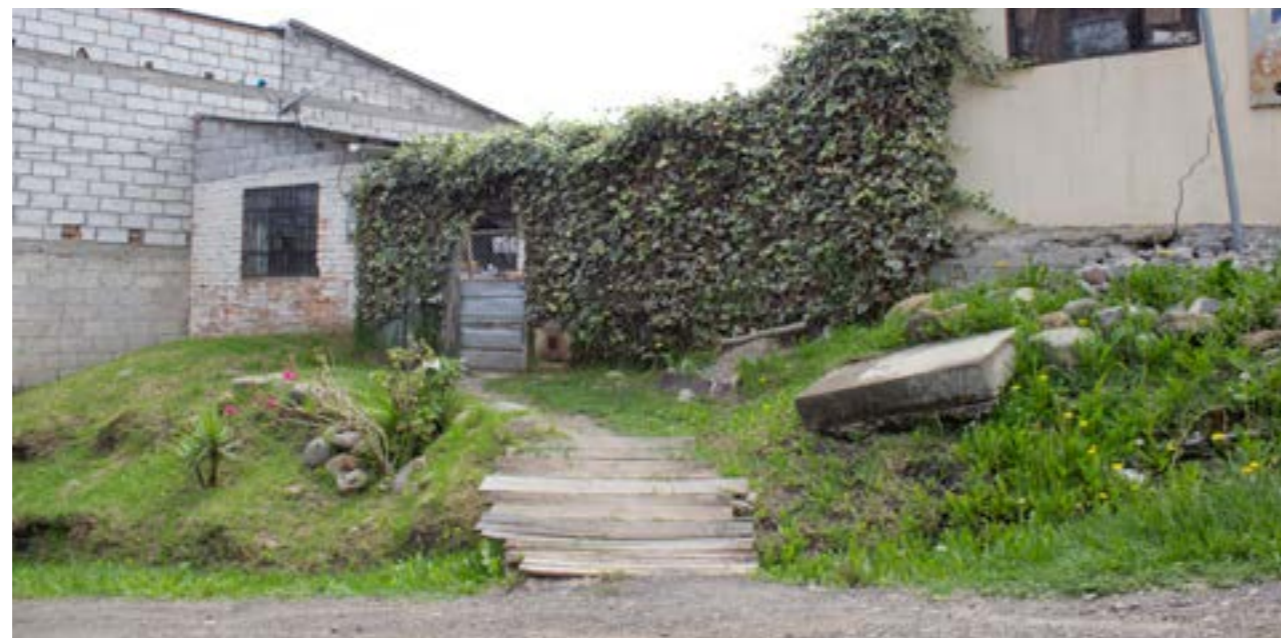
fotografía 54. Puente que conecta vivienda - calle fuente: Elaboración propia
