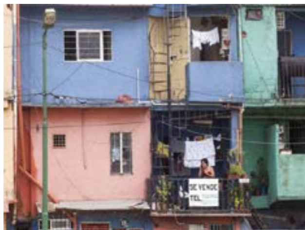
fotografía 04. Fachada de las vivienda en el barrio Villa 31 Argentina fuente: Ricardo Ceppi
