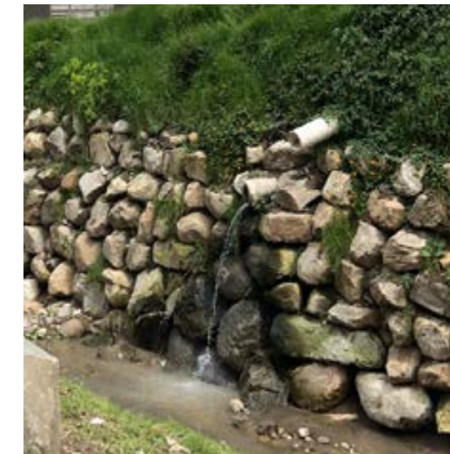
fotografía 53. Desagüe de agua fuente: Elaboración propia
