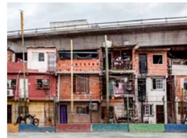
fotografía 06. Fachada de las vivienda en la Villa 31 Argentina fuente: Ricardo Ceppi
