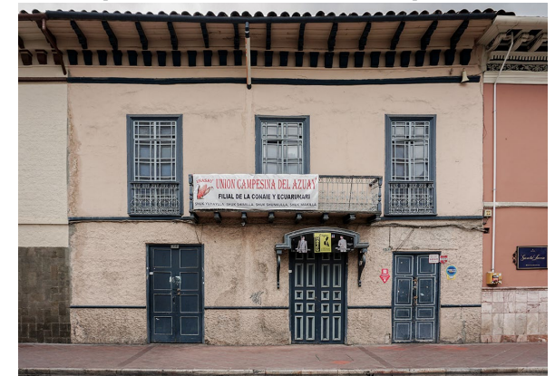
Imagen 49. Vista hacia edificaciones de la manzana. Fotografía de la autora. Tesis de grado. Ana María Ugalde Granado.
