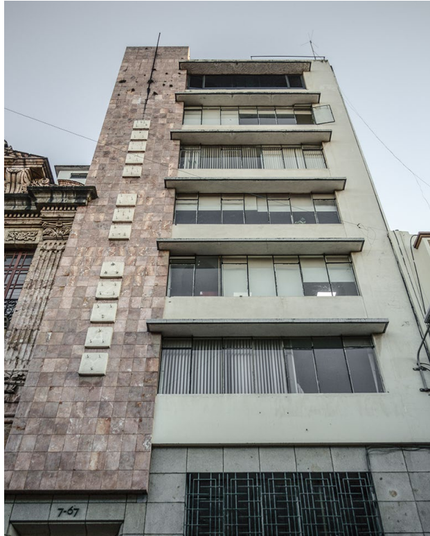
Imagen 11. Edificio Anexo. Fotografía de la autora.
