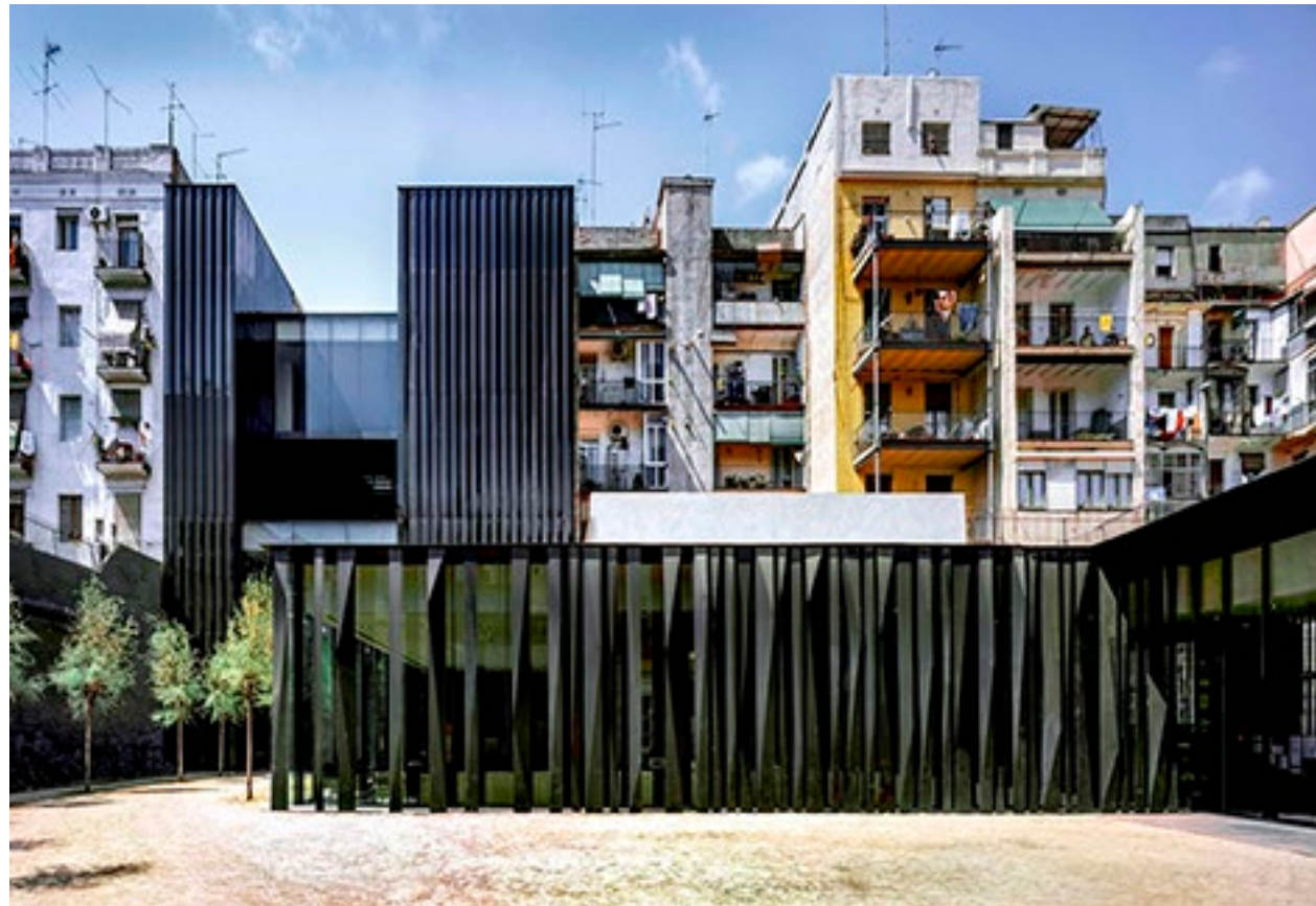
Imagen 24. Vista desde el interior del proyecto. Fotografía de Hisao Suzuki.
