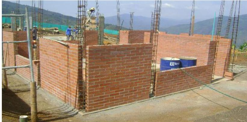
Figura 2.2 Ejemplo de construcción de una vivienda de mampostería confinada
