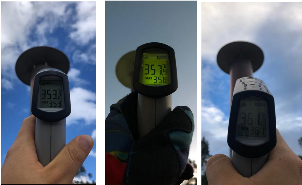
Figura 3.16 Medición de la temperatura en el escape del motor generador
