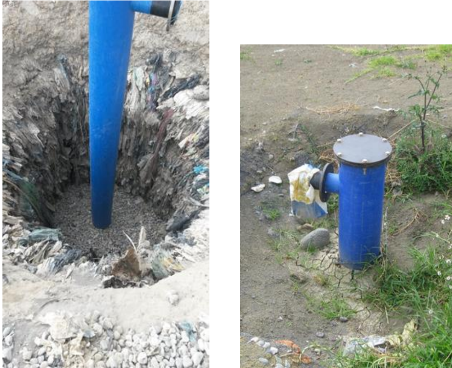
Figura 1.8 Pozos ubicados en el Relleno Sanitario de Pichacay
