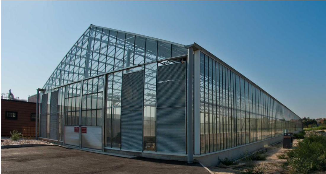
Figura 2.3 Invernadero para secado solar de lodos de última generación
