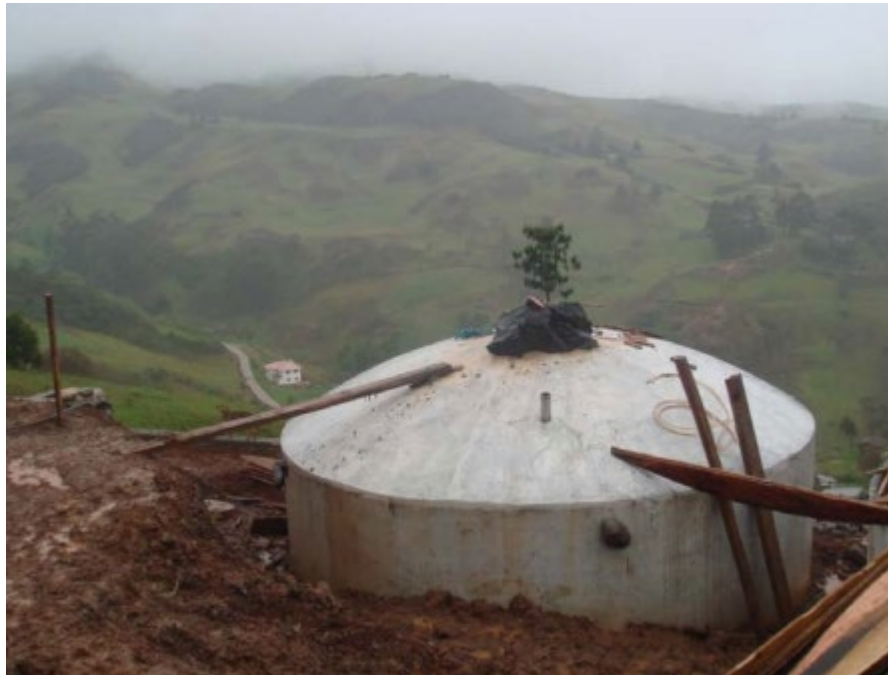
Figura 4.2: Tanque de ferrocemento filtro anaerobio. Fuente: (Carvalho, 2010)
