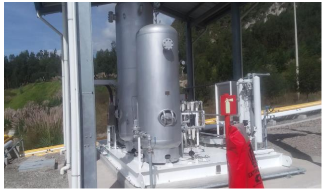
Fig. 4. Sistema Auxiliar de Aire comprimido
