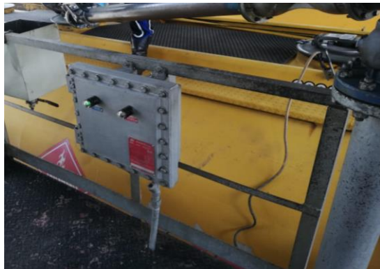
Fig. 13. Sistema de puesta a tierra
