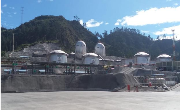
Fig. 1. Terminal nuevo de productos limpios Cuenca
