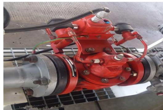
Fig. 11. Válvula de set-stop
