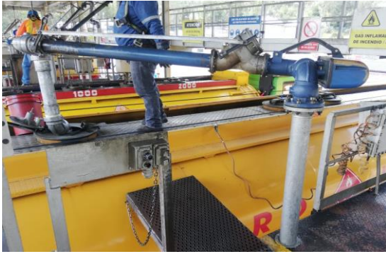
Fig. 12. Brazo de carga
