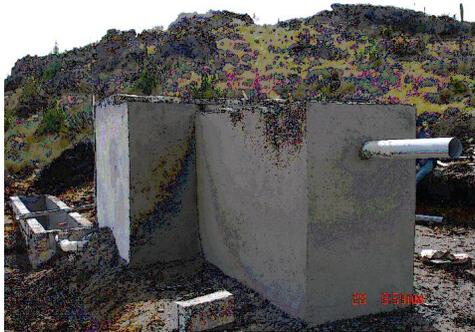
**Fotografía 1.5** Construcción del filtro UASB
