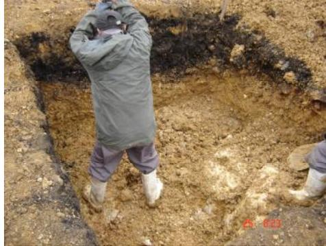
**Fotografía 4.3** Excavación para enterrado del tanque
