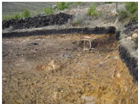
**Fotografía 4.2** Replanteo y nivelación del terreno
