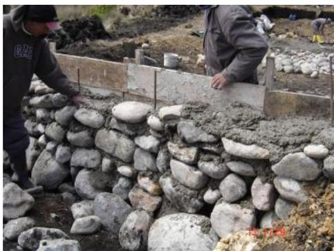
**Fotografía 4.10** Muro de contención
