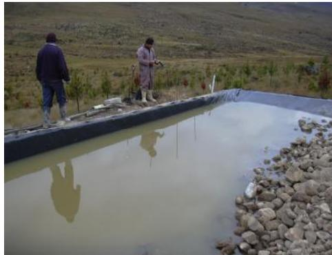
**Fotografía 4.19** Geomembrana que contiene fuga en el humedal
