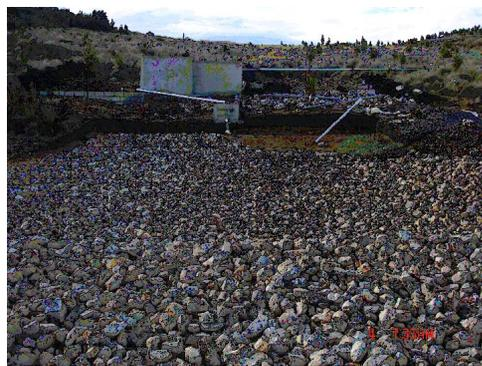
**Fotografía 4.14** Colocación de material pétreo
