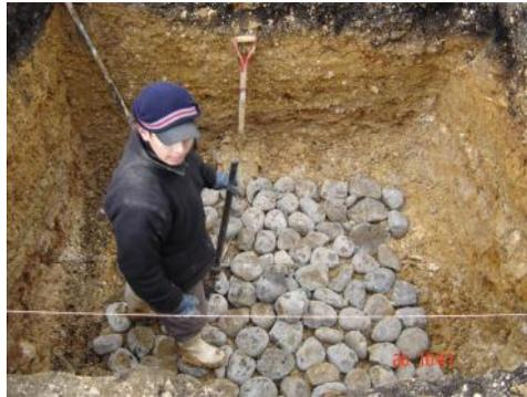
**Fotografía 4.4** Cimentación del tanque
