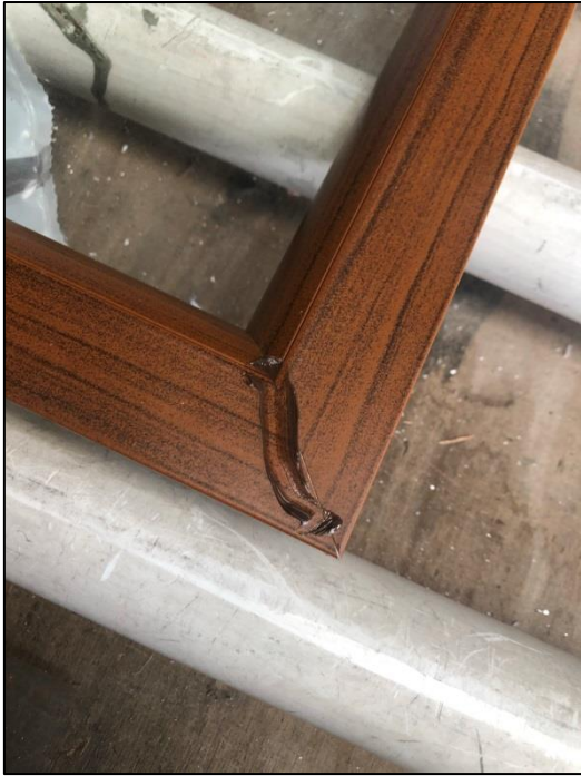
Figura 70. Ventana proyectable: sellado de bordes
