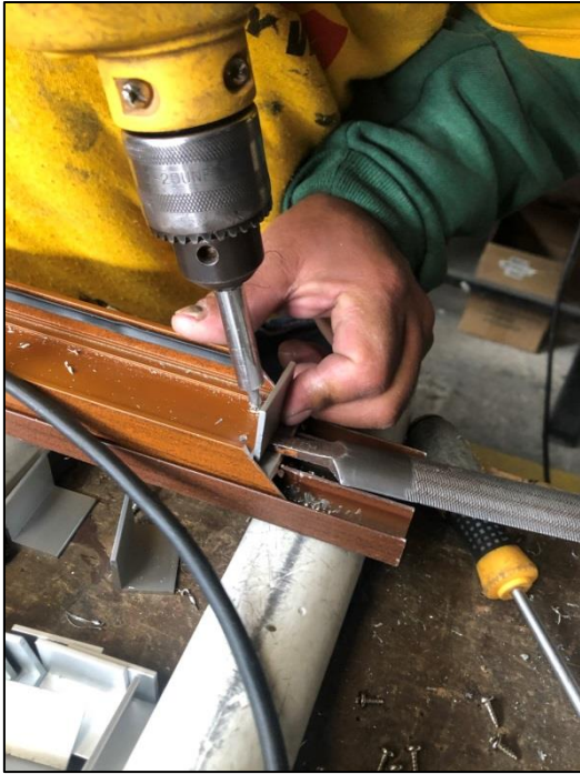
Figura 50. Ventana proyectable: perforaciones para anclajes
