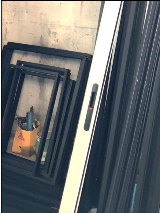
Figura 31. Puerta corrediza europea: cerradura acoplada
