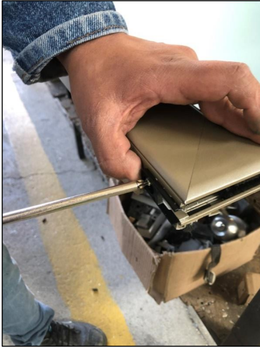
Figura 41. Puerta corrediza europea: instalación de guías en las hojas
