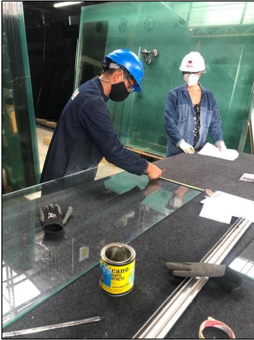
Figura 68. Ventana proyectable: verificación de medidas para corte de vidrio
