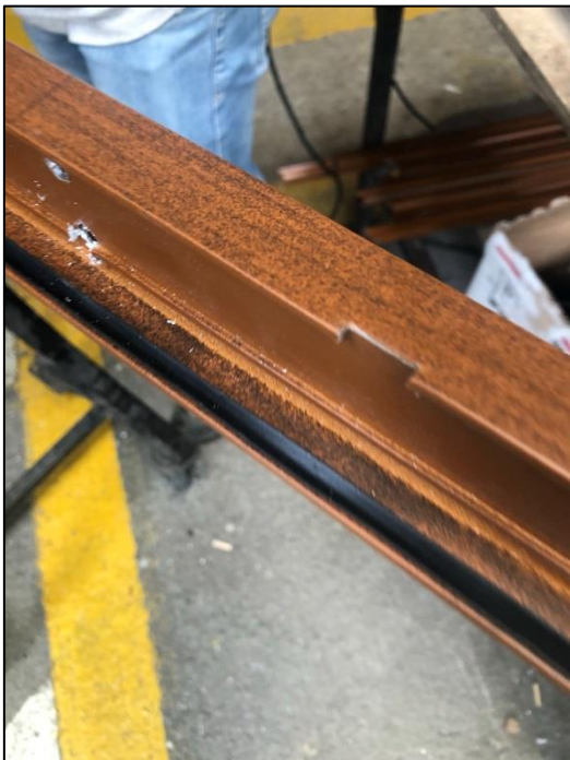
Figura 55. Ventana proyectable: desfogue en hoja fija
