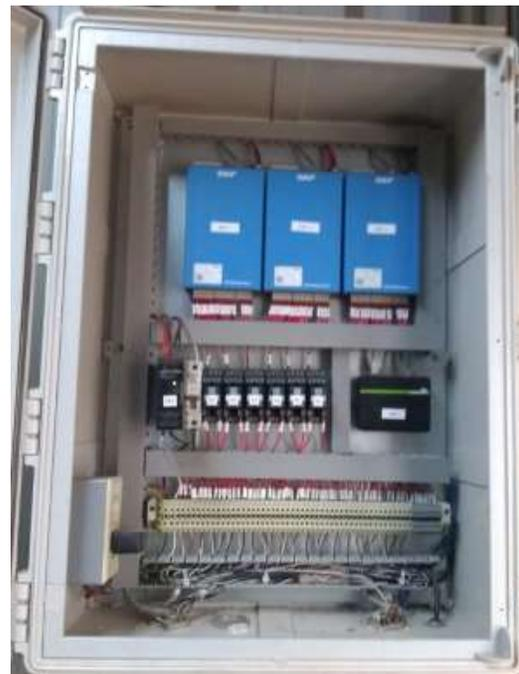
Fig. N°9 Equipos recolectores de datos SKF IMX8. Fuente: Hivimar.
