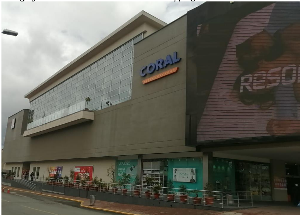
Fotografía # 1: Centro Comercial Batan Shopping.
