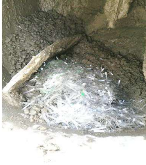
Fotografía 3-1 Inclusión de Fibras PET dentro de tolva con hormigón fresco. Fuente: Autores
