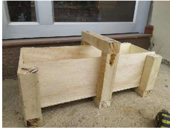
Fotografía 3-4 Vista lateral del Encofrado.
