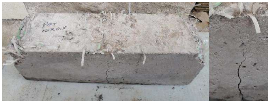
Fotografía 5-7 Fisura Viga PET 10*0.5. Fuente: Autores
