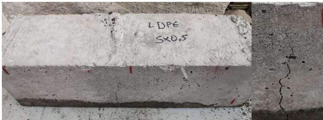
Fotografía 5-4 Fisura Viga LDPE 5*0.5. Fuente: Autores
