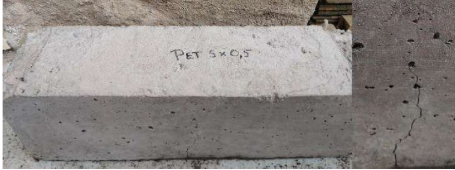
Fotografía 5-8 Fisura Viga PET 5*0.5. Fuente: Autores
