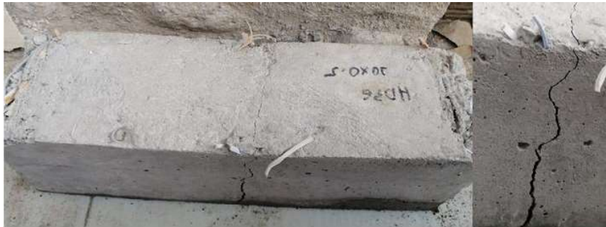
Fotografía 5-1 Fisura Viga HDPE 5*0.5. Fuente: Autores
