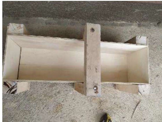
Fotografía 3-3 Vista en planta del Encofrado. Fuente: Autores
