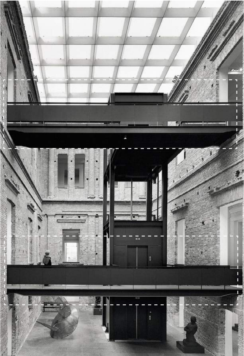
IMG 39. Intervención interna. Fuente: Iwan Baan and Bret Beyer, Courtesy of Diller Scofidio + Renfro.
