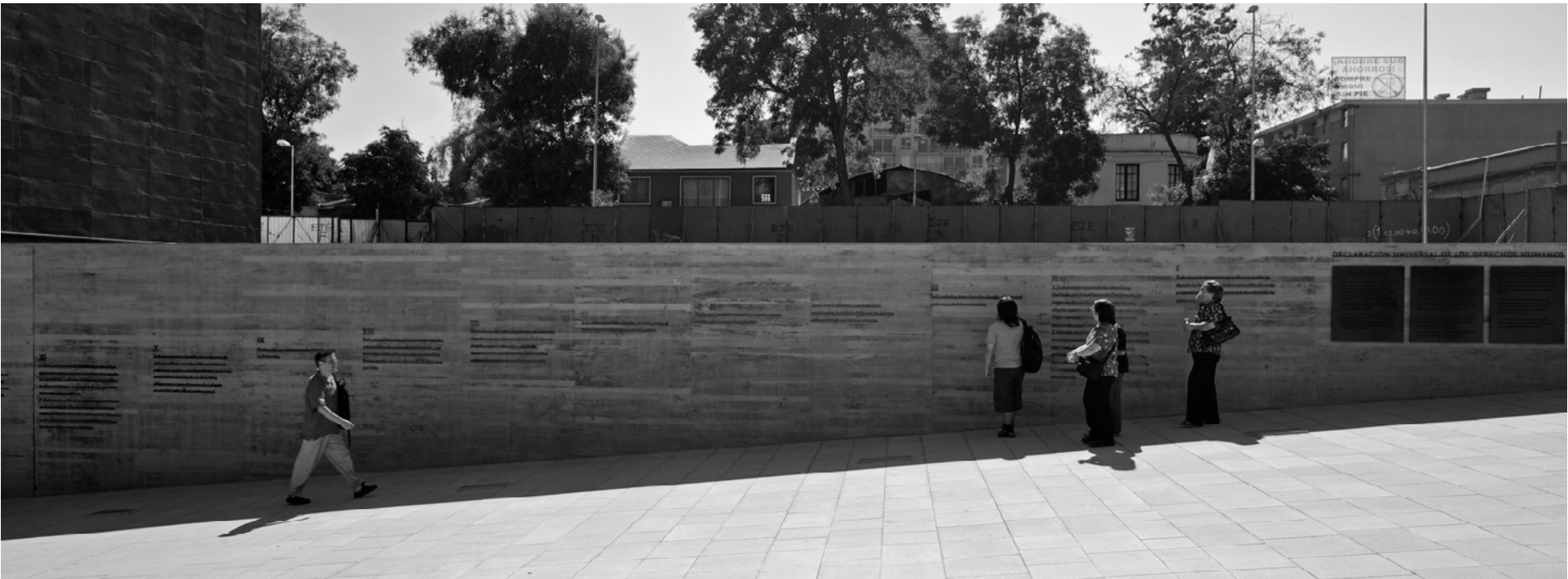
IMG 42. Acceso exterior. Fuente: Nico Saieh.
