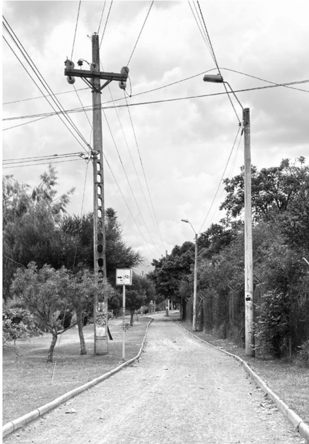
IMG 03. Calle Paseo 3 de Noviembre y Complejo Pumapungo. Fuente: Elaboración propia.
