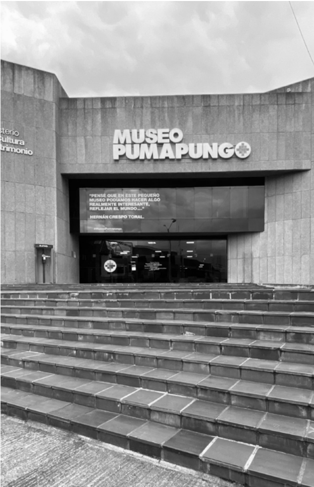
IMG 26. Fachada frontal . Fuente: Elaboración propia.
