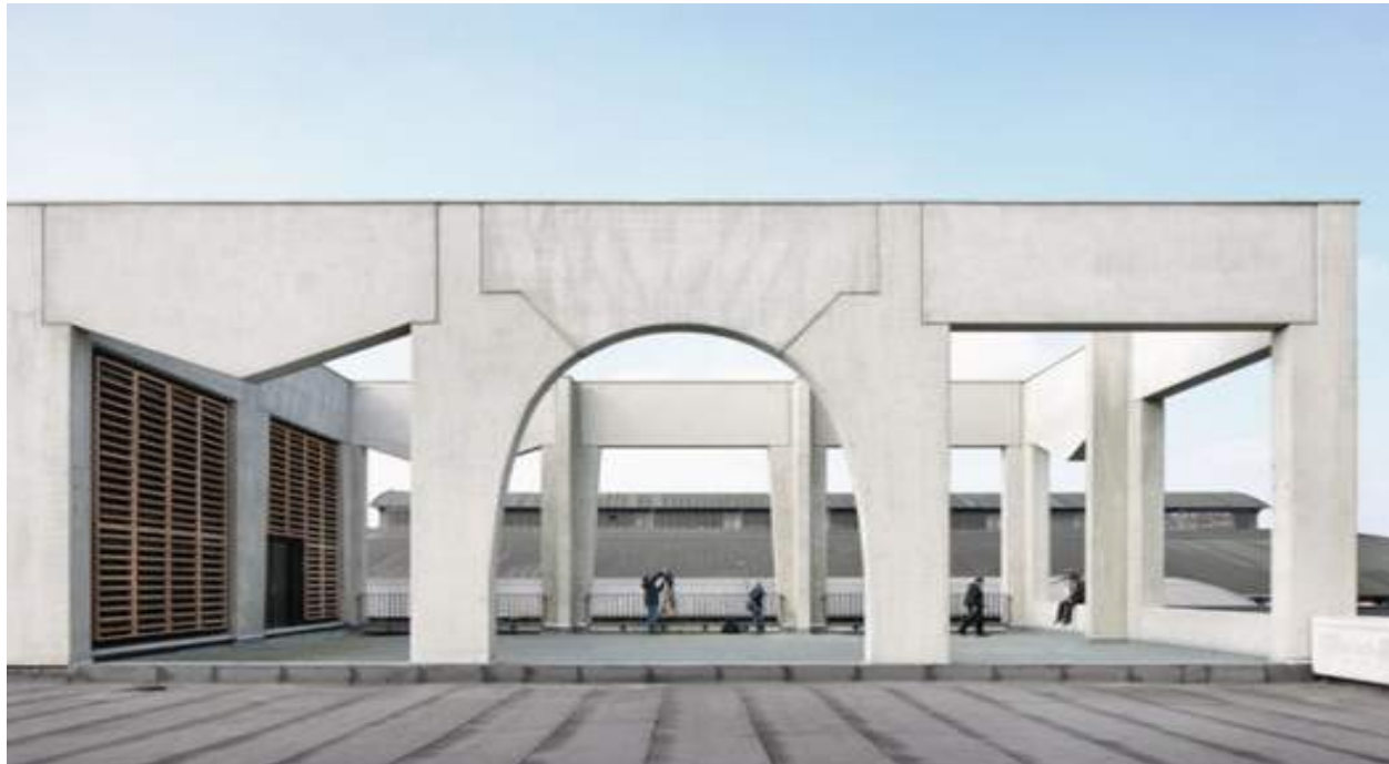
Fig. 26 Foto exterior Fuente: Filip Dujardin
