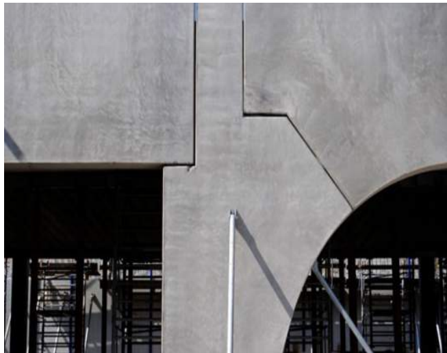
Fig. 27 Foto exterior Fuente: Filip Dujardin
