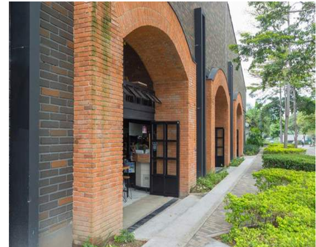
Fig. 31 Foto exterior Fuente: Julian Restrepo
