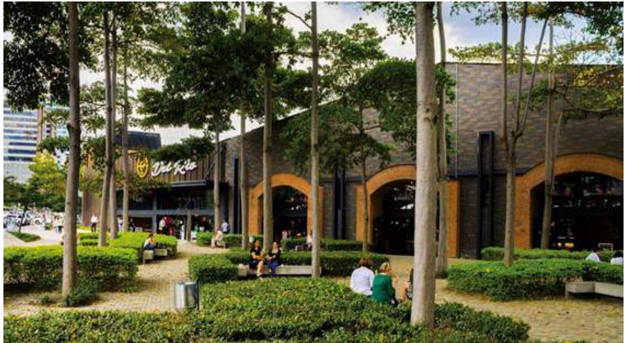
Fig. 29 Foto exterior Fuente: Julian Restrepo
