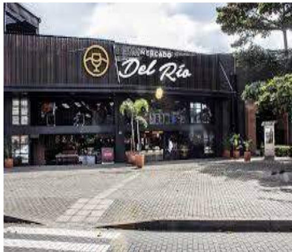
Fig. 30 Foto exterior Fuente: Julian Restrepo
