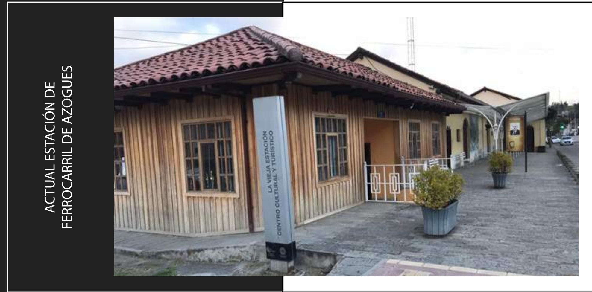
IMAGEN 45: VISTA FRONTAL DE LA EDIFICACIÓN, AÑO 2021 FUENTE: AUTOR
