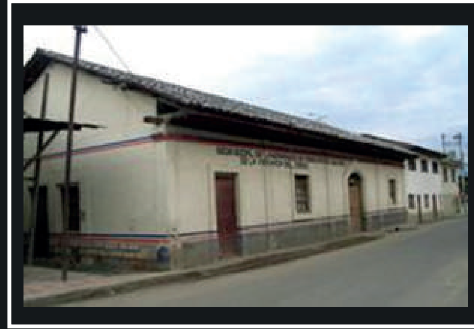
Imagen 33: Antigua Estación de Ferrocarril, primer bloque construido, fachada frontal, año 2004 Fuente: restauración de la antigua estación del ferrocarril de azogues
