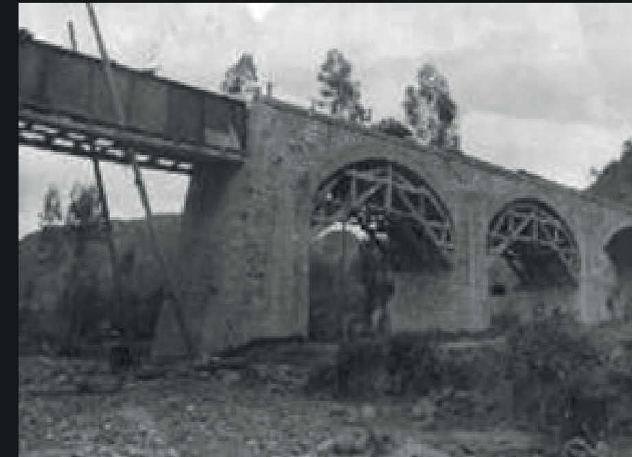
Imagen 12: Construcción del puente Cevallos en la ciudad de Azogues, en 1945 aproximadamente, por donde iba a cruzar el Ferrocarril Fuente: I. Municipalidad de Azogues
