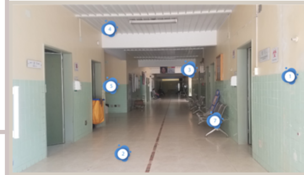
Imagen 13. Pasillo Interior Fuente: Fárez, E. (2021).
